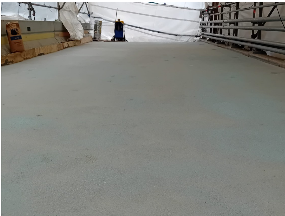
Kuva 6. Epoksiivistetty sillan kansi (Koljonen 2024)
