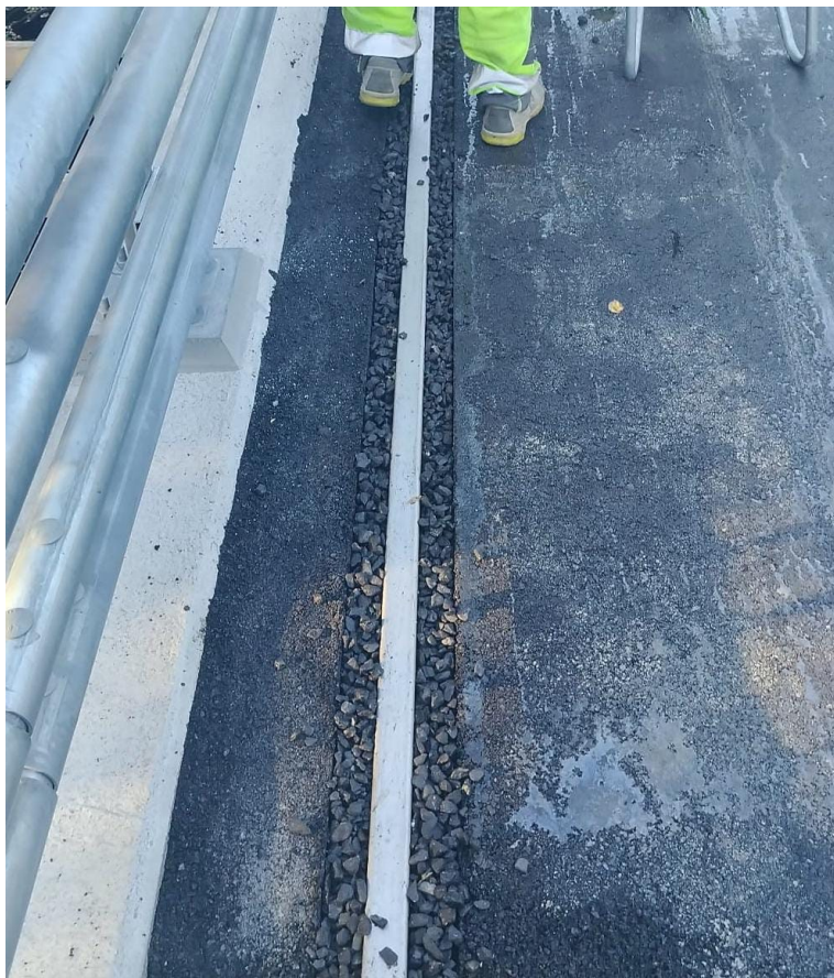
Kuva 10 Kannen putkisalaoja (Koljonen 2024)
