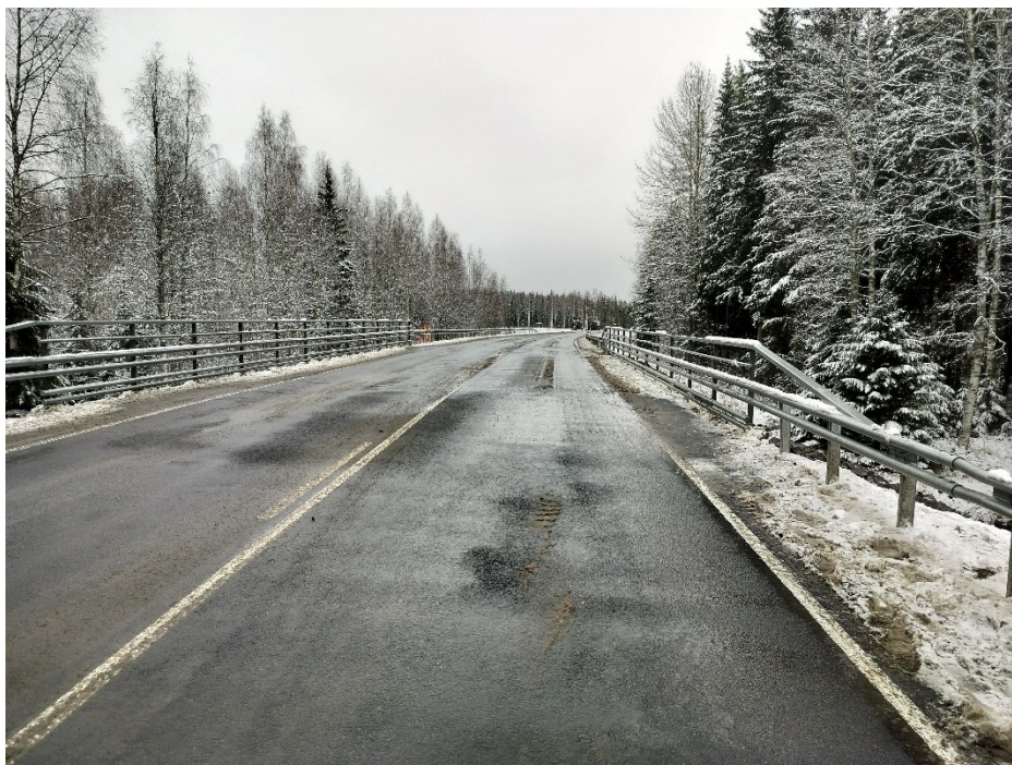
Kuva 9 H2-luokan uusitut siltakaiteet (Koljonen 2024)
