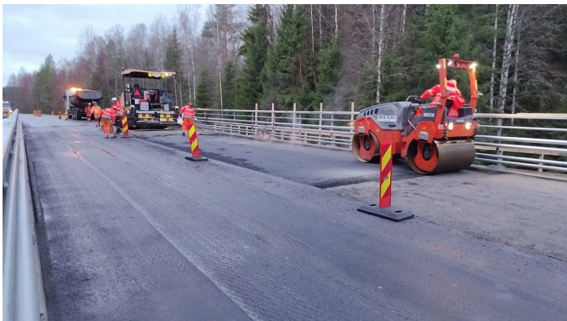
Kuva 8. Päällysteen uusiminen (Koljonen 2024)
