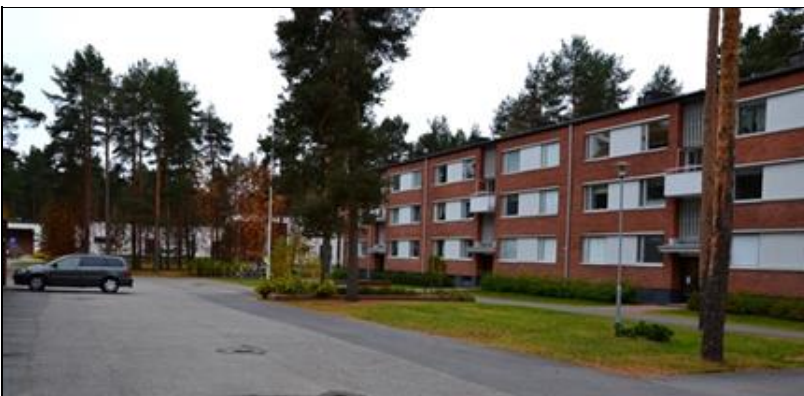
As Oy Kotivarpusen uusittu piha (Jenna Ylikauppila 7.10.2014)
