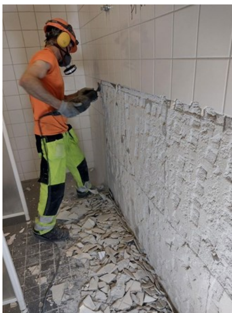
Kuva 7. Laattojen irrottaminen (Karvonen, J. 2024)
