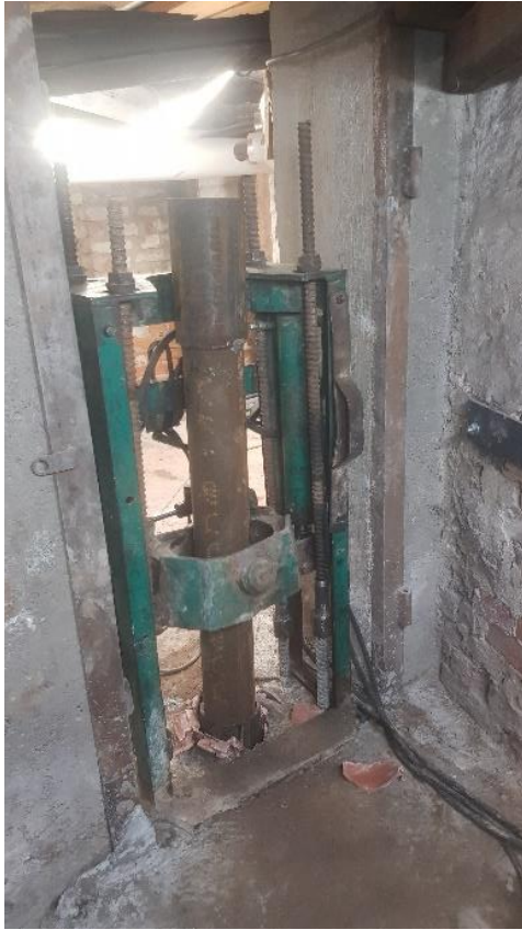
Kuva 9. Puristuspaalun alkupuristus käynnissä (Hento 2024).
