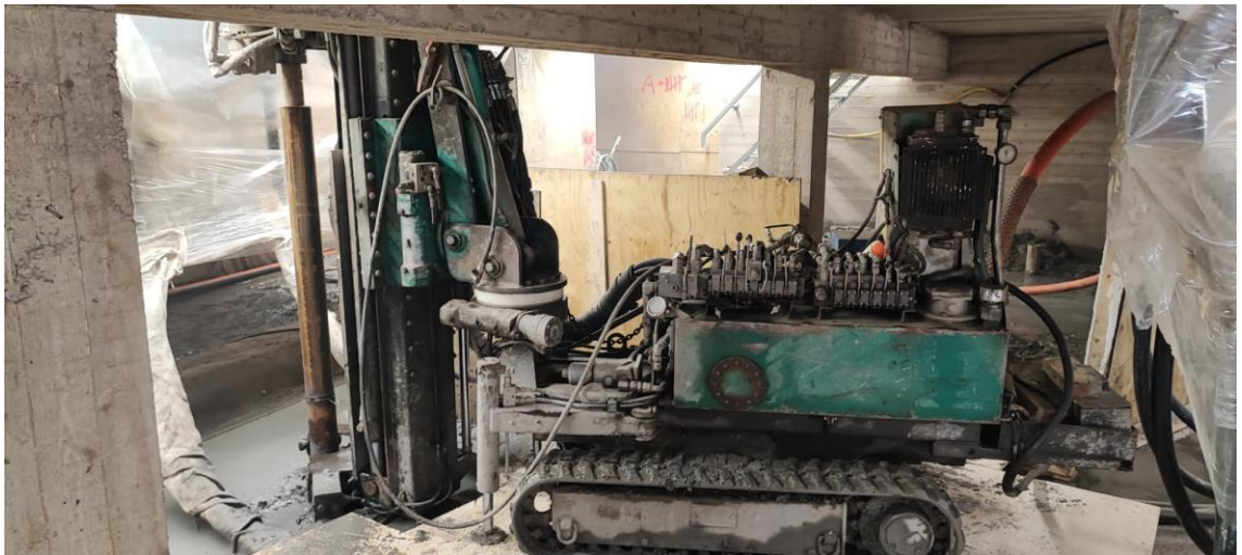
Kuva 4. Porapaalun asennusta kellarituloissa (Salviander, O. 2023).
