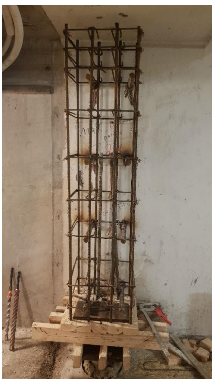
Kuva 15. Pilasterin raudoitus (Hento 2023).
