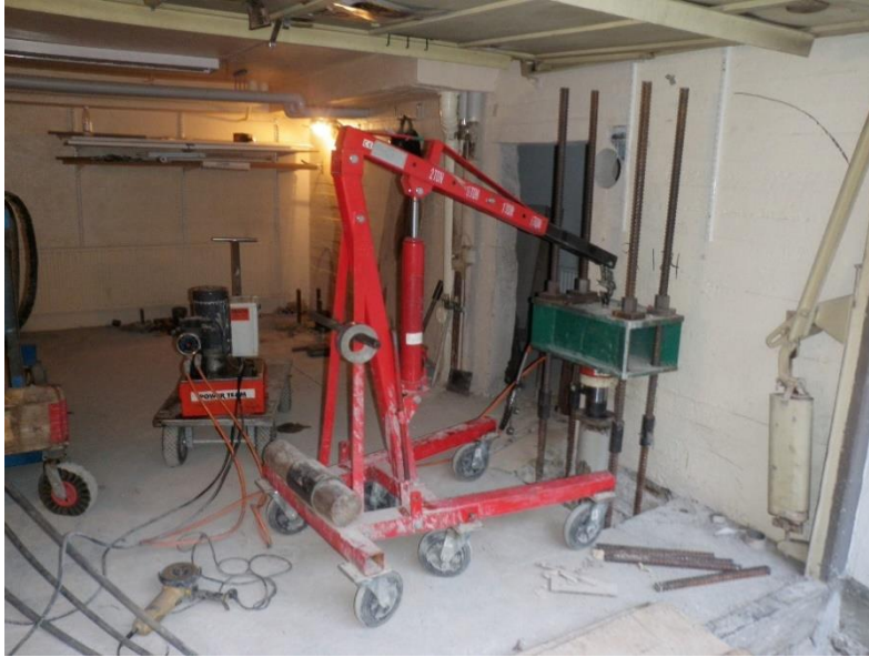
Kuva 10. Puristuspaalun loppupuristus käynnissä (Salviander, O. 2018).
