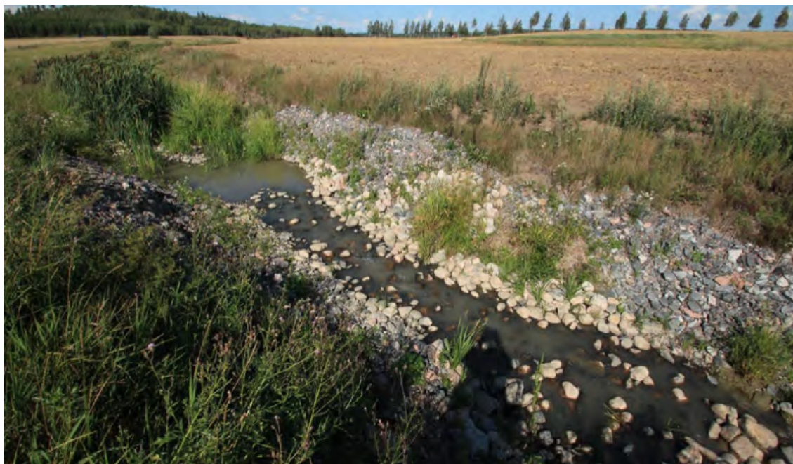
KUVA 4. Kiviverhoiltu pohjapato yhden vuoden kuluttua rakennustöistä Liejuojan turvepellolla. Kuva: Juha Siekkinen/Kosteikkomaailma (Siekkinen 2024)
