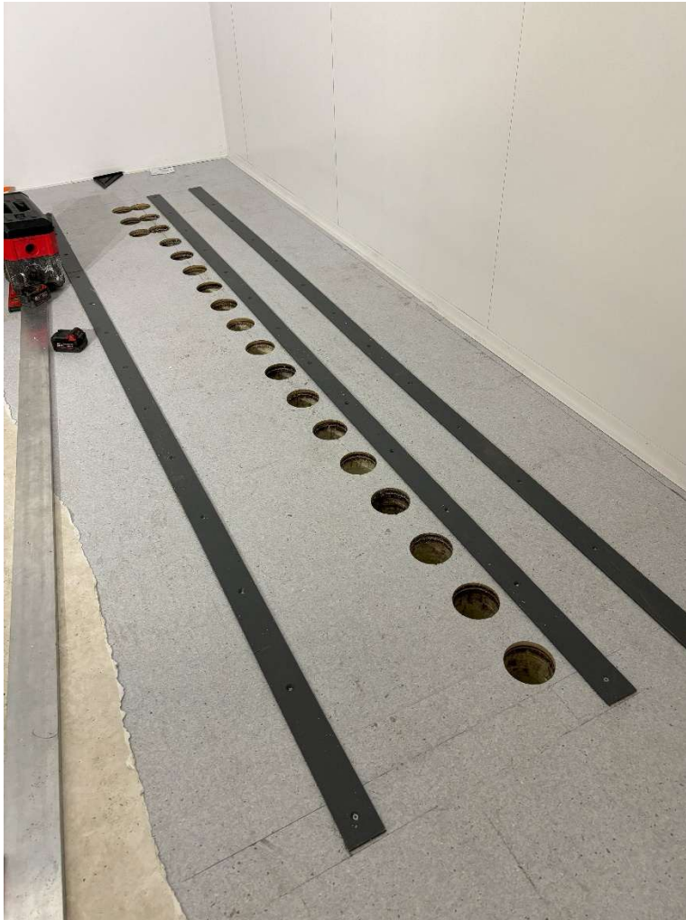
Kuva 7. Asennusalue tasoitettu kiskoilla.
