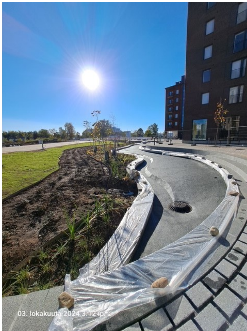
Kuva 8. Hulevesiallas vedeneristyspinnoituksen jälkeen.
