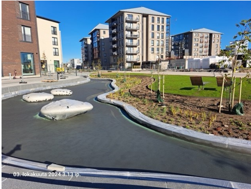
Kuva 7. Vedeneristyspinnoitus sekä hulevesialtaan kuukivet.
