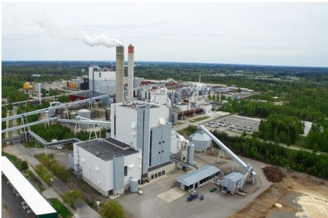
Kuva 2. Kaukaan Voiman biovoimalaitos (Pohjolan Voima 2019)
