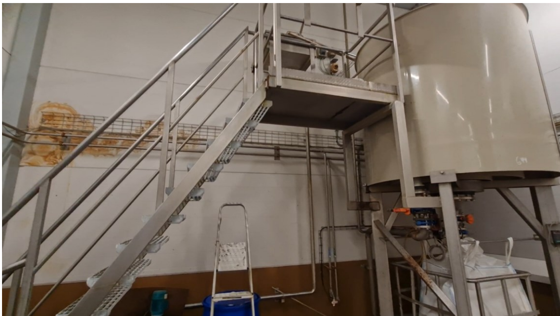
Kuva 4. Esikäsitelysäiliö, portaikko ja sakkasäkki ennen purkamista vanhasta tuotantolaitoksesta.
