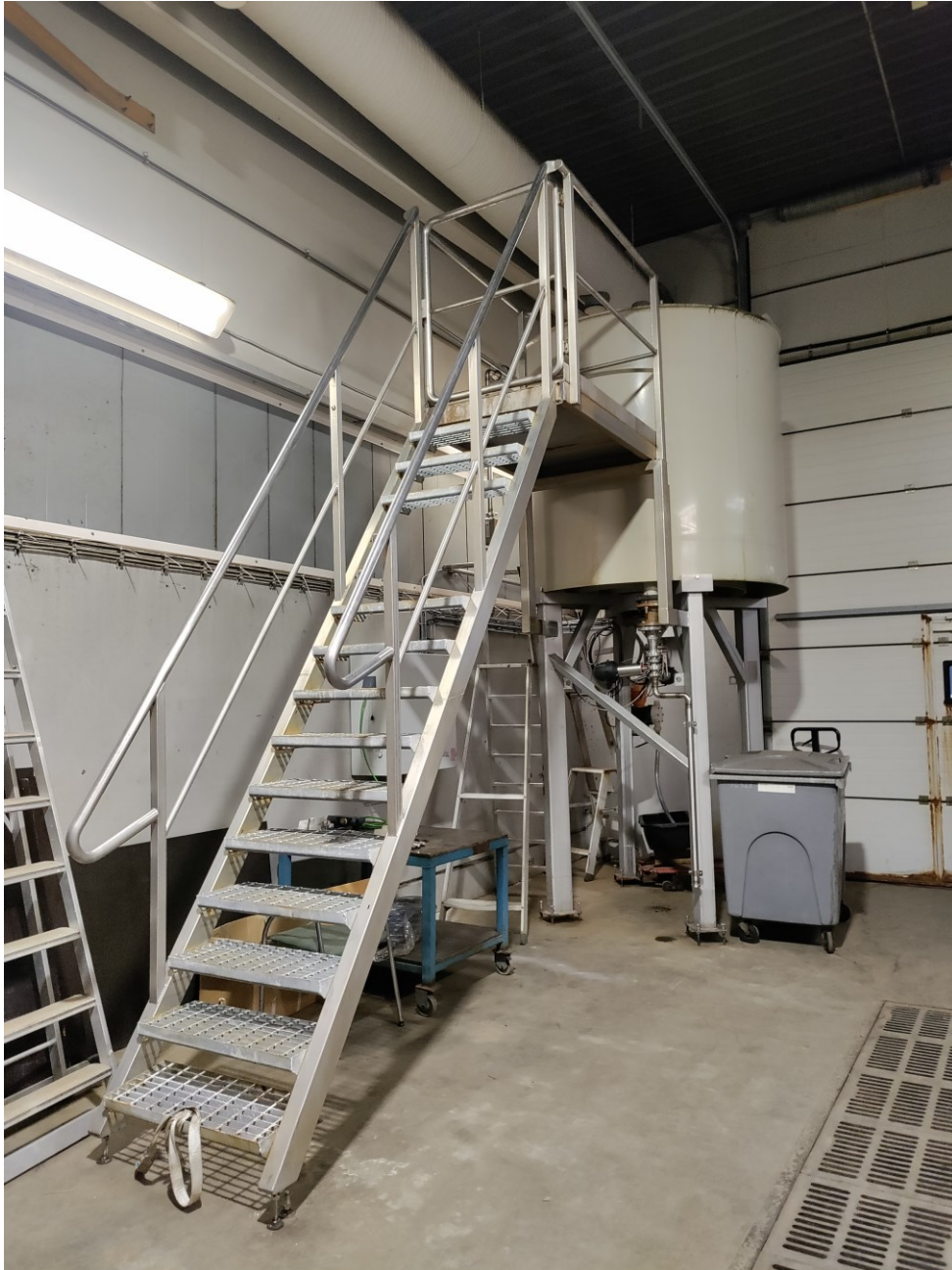
Kuva 10. Vesienkäsittelylaitteisto asennettuna paikalleen.
