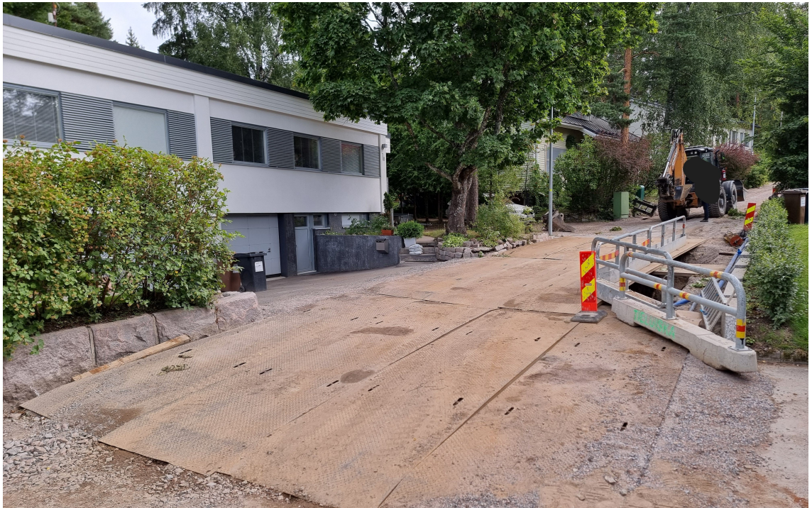
Kuva 9. Kuvassa kaivanto peitetty ajosilloin työalueen ohittavaa liikennettä varten. Pelkästään tässä kuvassa on näkyvillä 12 ajosiltaa ja raskassuojia, jotka olivat järjesteltävä paikalleen aina, kun kaivannon ohi tuli järjestää kulkumahdollisuus.
