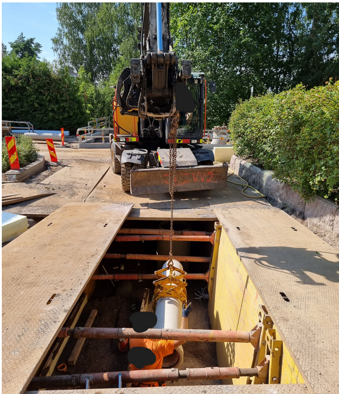
Kuva 5. Kuvassa vesihuoltokaivanto keskellä katualuetta.
