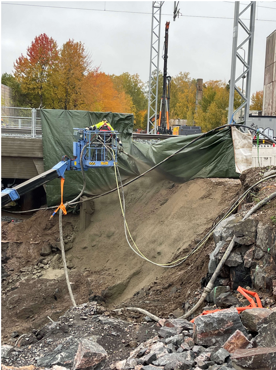
KUVA 27. Ruiskubetonointi käynnissä (Aaltonen)
