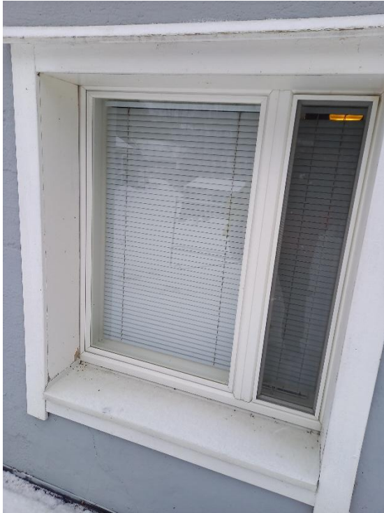
Kuva 56 Alakerran uusittu ikkuna
