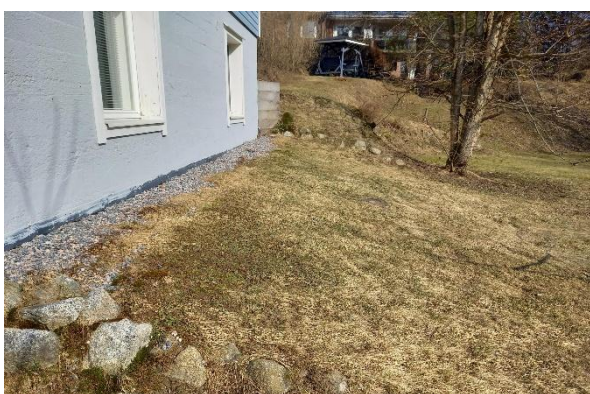
Kuva 47 Eteläsivulla pintamaa viettää riittävästi pois päin rakennuksesta
