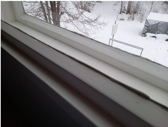
Kuva 55 Eteläisen sivun ikkuna
