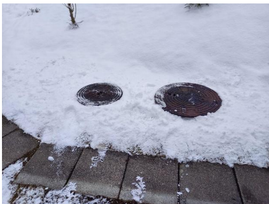
Kuva 18 Alapihan betonikaivot. Wc, keittiön ja alakerran vedet tänne, josta kunnan viemäriin
