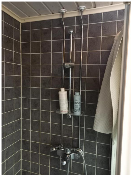
Kuva 65 Wc suihku tila
