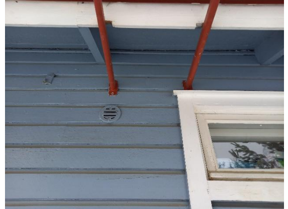
Kuva 72 Pohjoisen sivun yläpohjan ilma venttiilit
