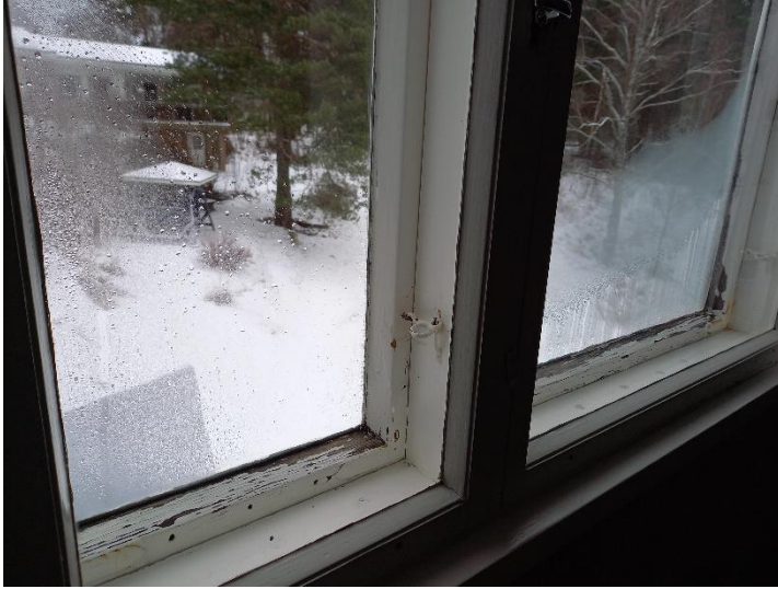
Kuva 54 Idänpuoleinen päätyikkuna yläkerrassa
