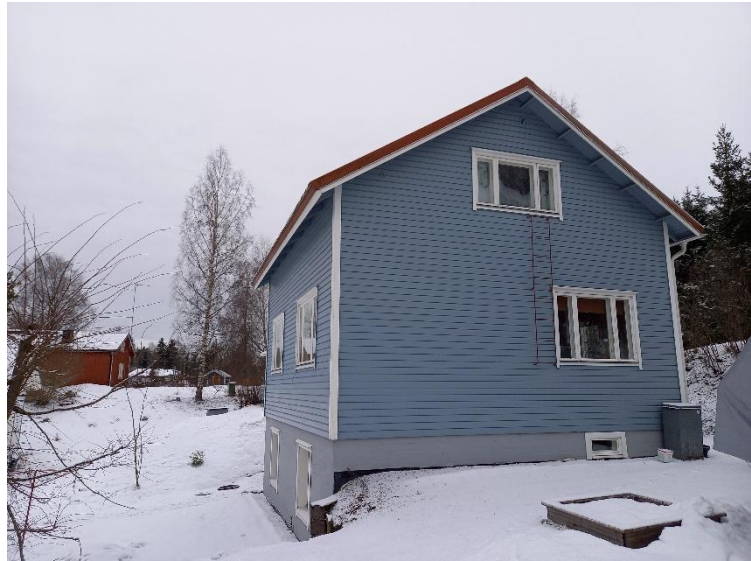
Kuva 35 Idänpuoleinen julkisivu ja vanhat talotikkaat
