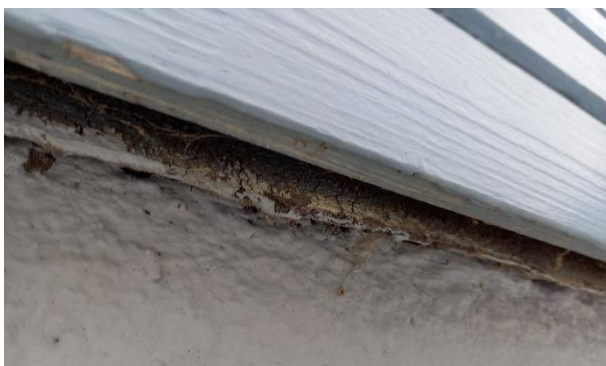
Kuva 41 Kattohuopa pinnoite ja ulkovuorauslaudoitus
