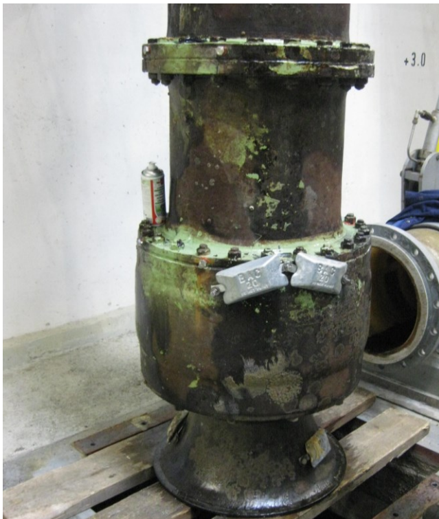
Kuva 9. Uusien sinkkien asennus merivesipumppuun [18]. Kuva ei liity insinööriyössä käsiteltäviin merivesipumppuihin.
