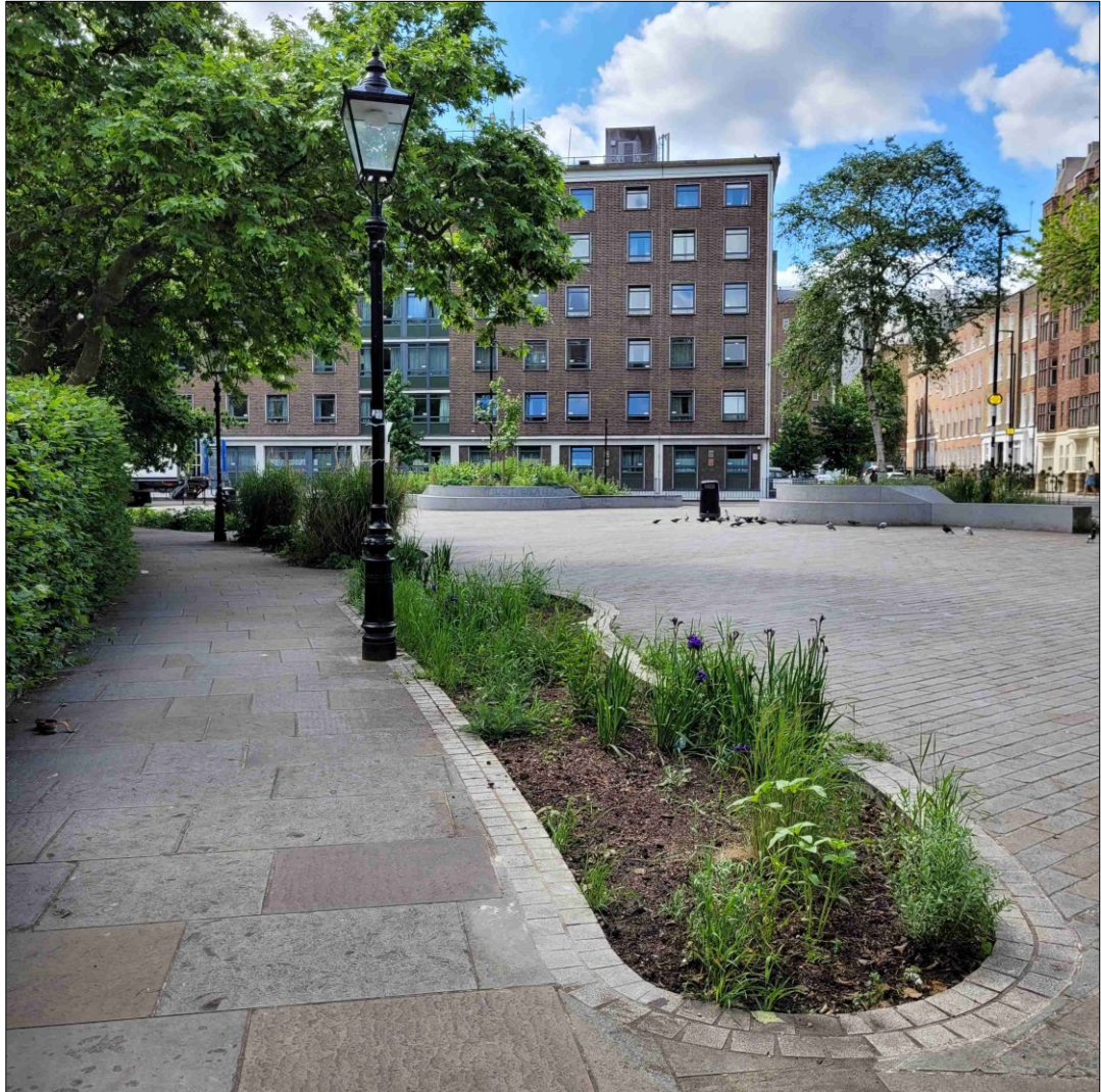
Kuva 2. Lontoossa sijaitsevan kadun reunassa oleva imeytyspainanne ylivuotokaivoineen (Aarnio, 2024).
