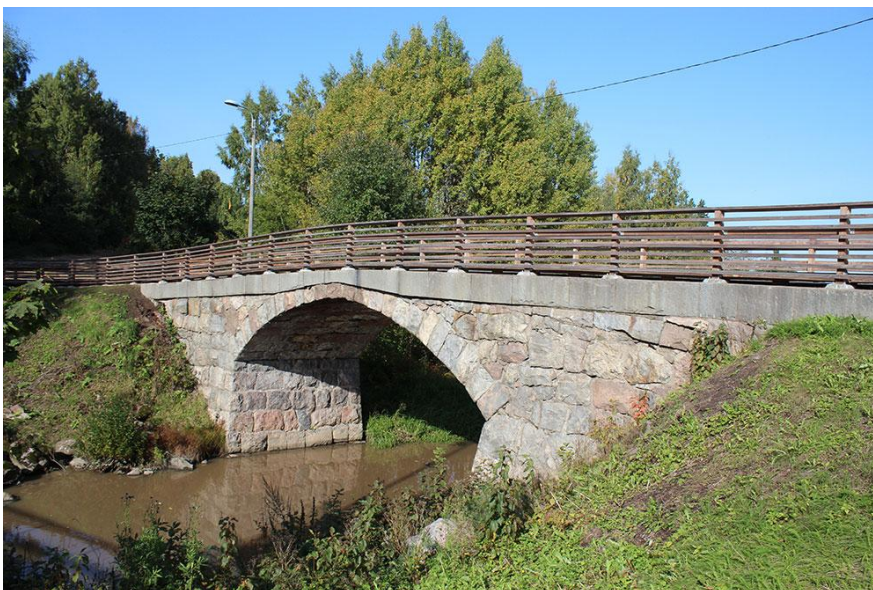
Kuva 1. Vuonna 1897 rakennettu Hakkilan kiviholvisilta (Hagerlund 2018)
