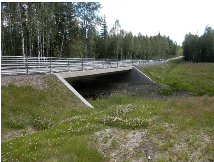
Kuva 14. Torasjoen teräsbetonirakenteinen silta
