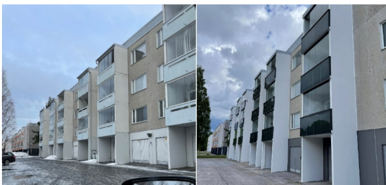
Kuva 19. Osittain uusitut parvekkeet. (Järvinen, 2024)
