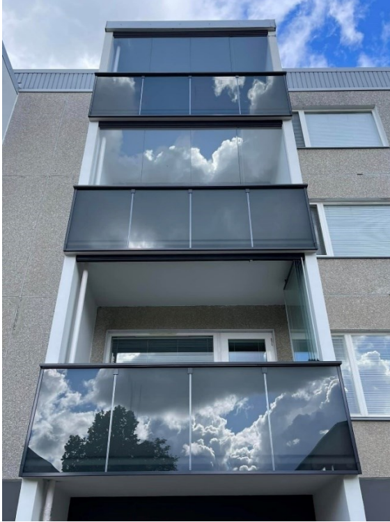
Kuva 21. Uusi parvekelasitus asennettuna. (Järvinen, 2024)
