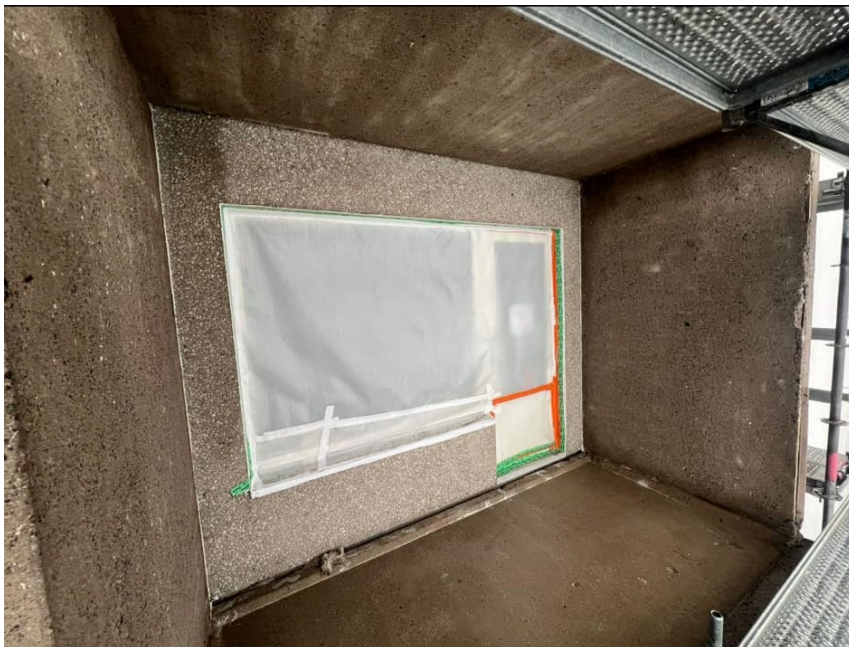
Kuva 23. Parveke hiekkapuhallettu ja vanha kaide poistettu. (Järvinen, 2024)
