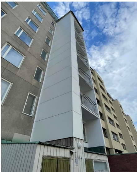
Kuva 18. Levyverhouksella korjattu parvekelinja. (Järvinen, 2023)
