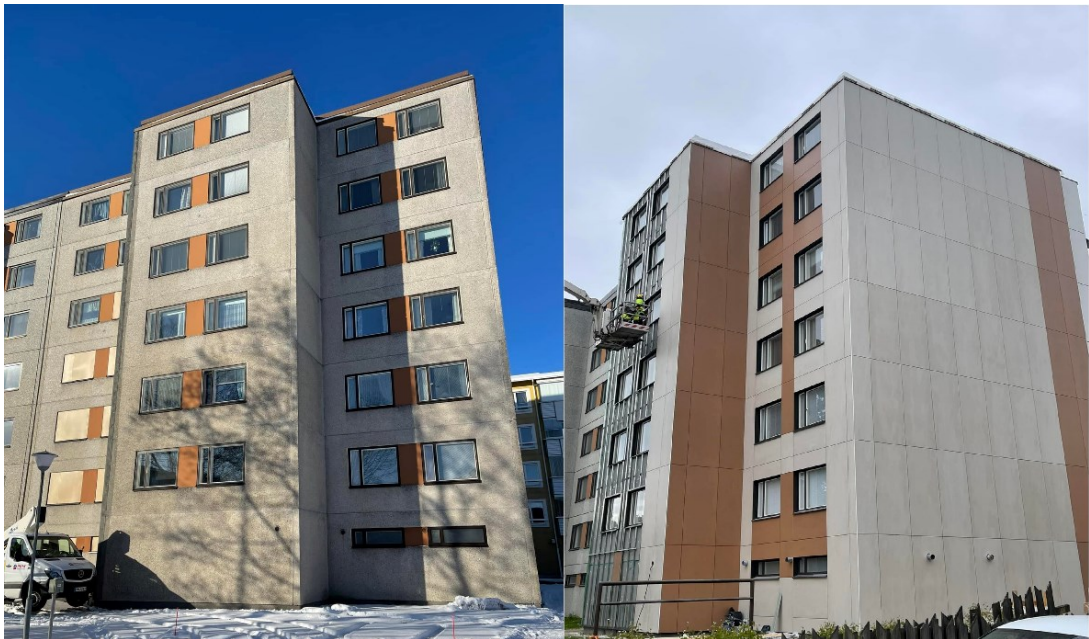
Kuva 9. Vanhan betonielementtjulkisivun vaihtuminen levyverhoukseen. (Järvinen, 2023)
