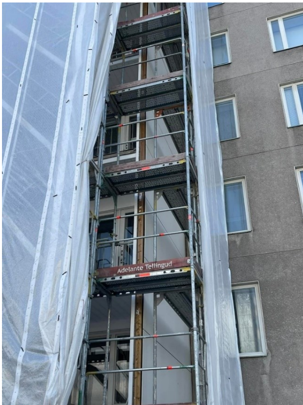
Kuva 22. Parvekelinjan levytystyö. (Järvinen, 2024)
