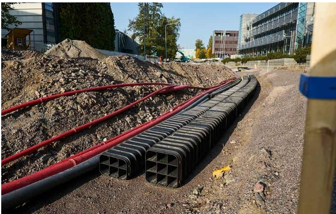
KUVA 12. Cubis-kaapelisuojojärjestelmä Raide-Jokerin työmaalla (Rudus)
