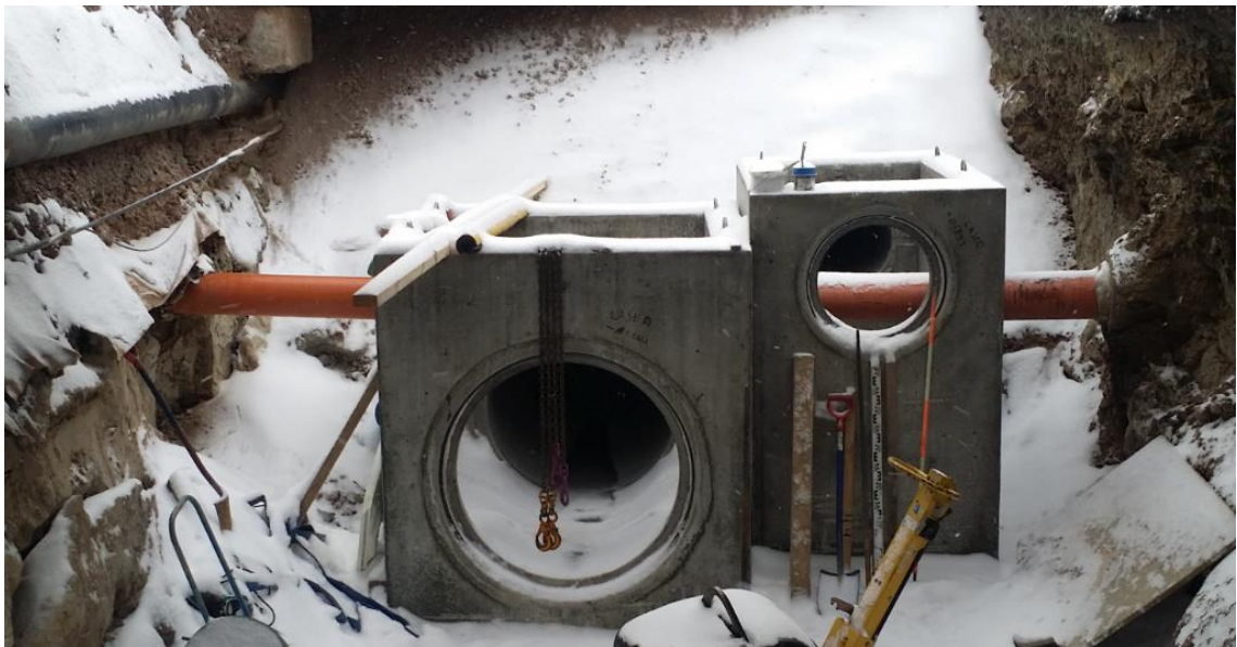
KUVA 13. Kuutiokaivot Mechelininkadun työmaalla (Ruskon Betoni n.d.)
