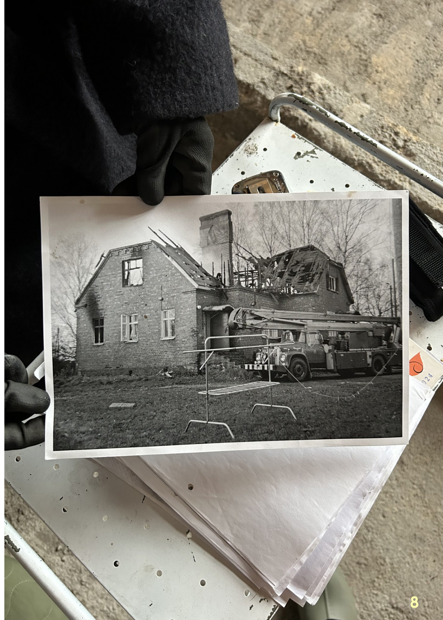
Kuva 2. Kohde tulipalon jälkeen
