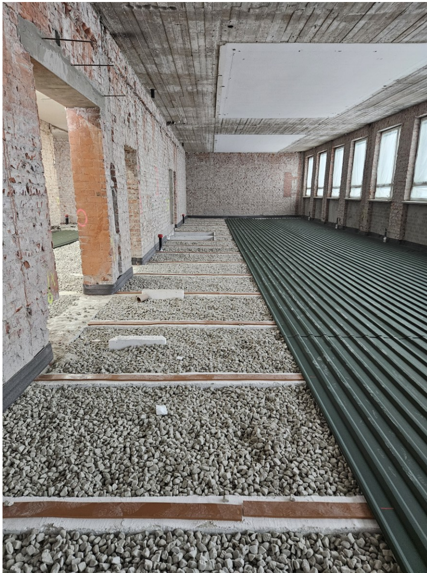
KUVA 7. Palkkien päälle asennettu sylomer kaistat. (Pätsi 2024.)
