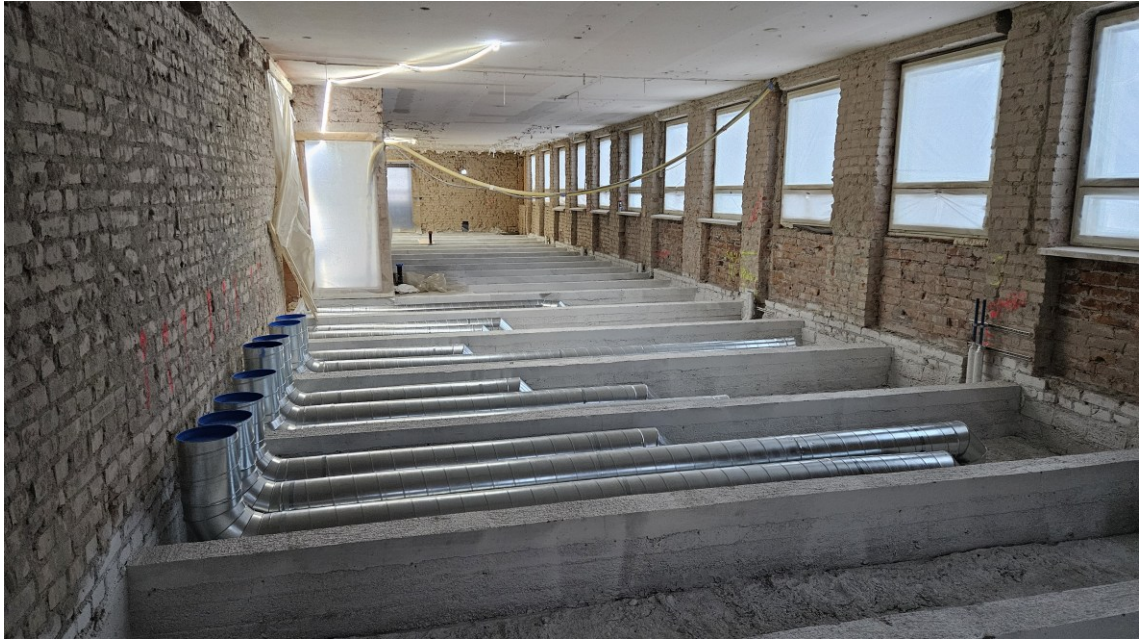
KUVA 6. Palkkivälit puhdistettu, hiekkapuhallettu ja pölynsidontamaalattu. (Pätsi 2024.)
