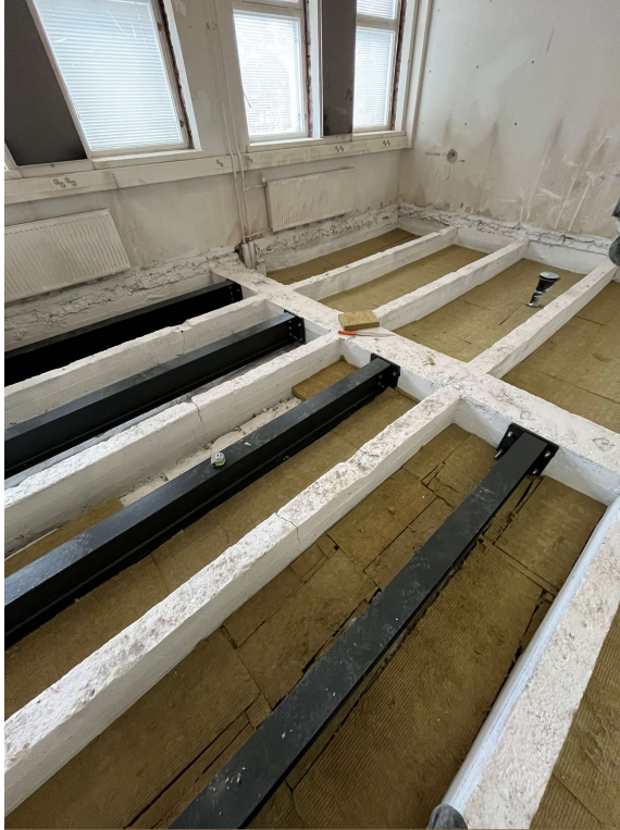
KUVA 13. Teräspalkeilla palkkiväleistä vahvistettu alalaattapalkisto. (Kuva: Eeli Mikkola)
