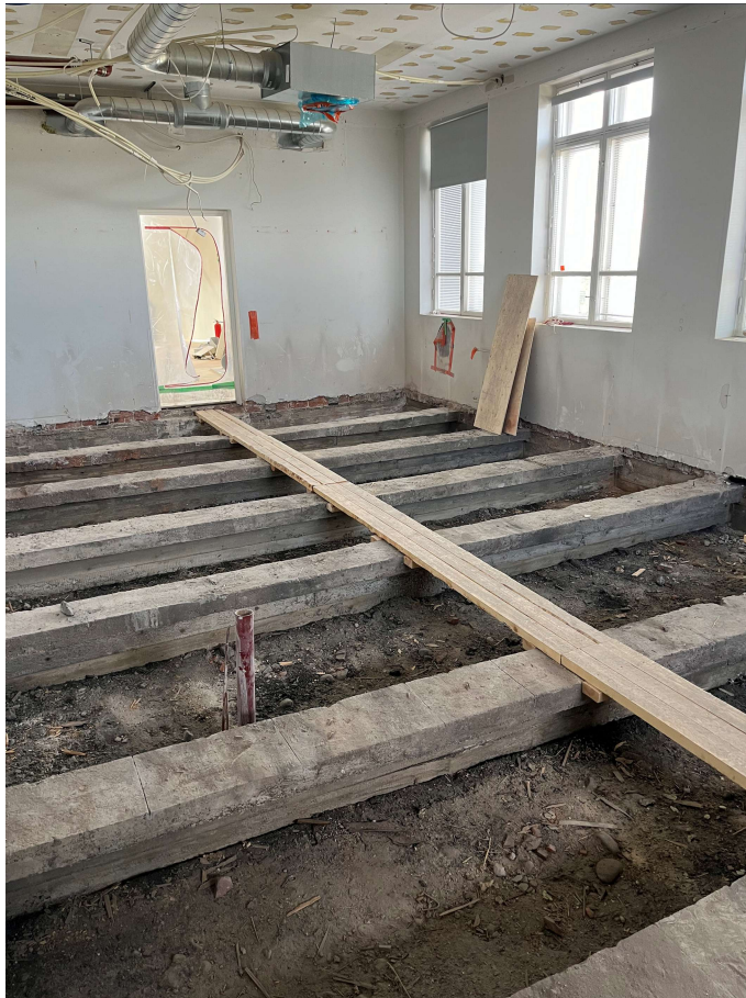
KUVA 16. Alalaattapalkkiston päälle rakennettu kulkusilta. (Kuva: Eeli Mikkola)
