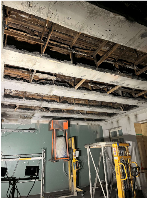
KUVA 10. Sahaamalla alakautta avattu välipohja. (Kuva: Eeli Mikkola)
