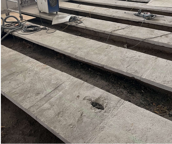
KUVA 7. Kaksoislaattapalkiston sahausessa ylälaattaan jätetty puristuskannas. (Kuva: Eeli Mikkola)
