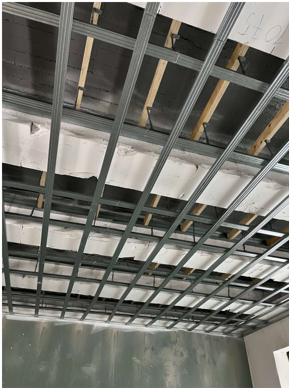
KUVA 14. Uuden alakaton runko kertopuusta ja peltirangasta rakennettuna. (Kuva: Eeli Mikkola)
