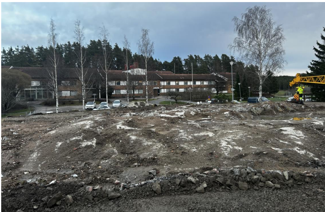
KUVA 6. Purettun rakennuksen alta paljastunut kallio. (Kuva: Puronummi, P. 2024)
