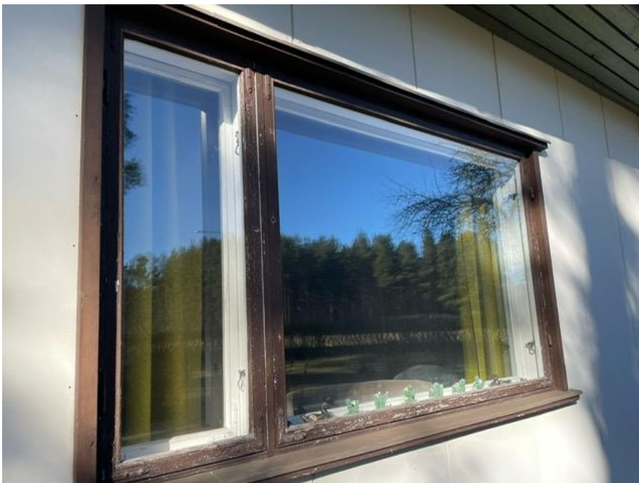
Kuva 10. Alkuperäinen ikkuna ulkopuolelta
