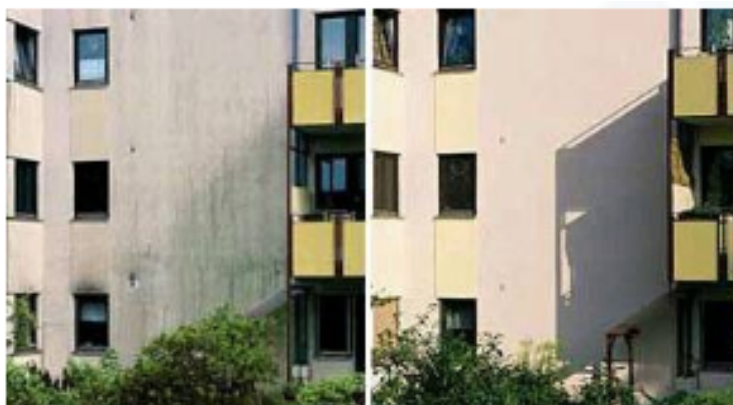
Kuva 16. Nanomateriaalilla pinnoitettu julkisivurappaus hylkii likaa [62.]
