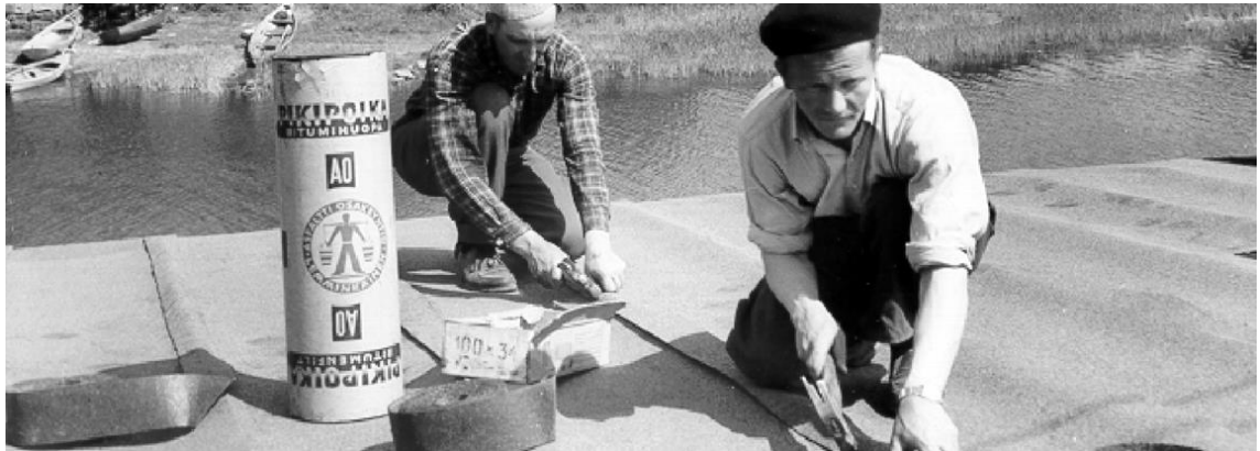
Kuva 10. Kattohuovan asennusta, materiaalina Pikipoika bitumikattohuopa [77.]. Pikipoika kiinnitysliimat ja kittaus tuotteet sisälsivät asbestia vuosina 1970-1979 [70, s. 98; 71, s. 18.].
