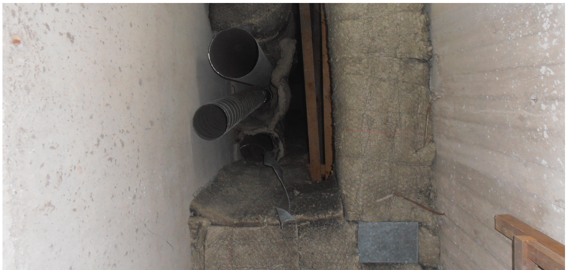
Kuva 26. 1970-luvun kohteen tekniikkakuilu. Kuva on otettu kun edellisen kerroksen purkutyöt on tehty ja siirrytään purkamaan seuraavan kerroksen kohdalta eristeitä.
