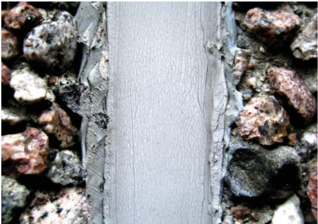
Kuva 14. Elementtisaumauksen korjauksen yhteydessä vanhaa massaa ei ole poistettu, joten PCB-yhdisteet ovat imeytyneet vanhasta massasta uuteen saumaan.
