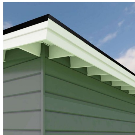
Moderni avoräystäs puuosineen
