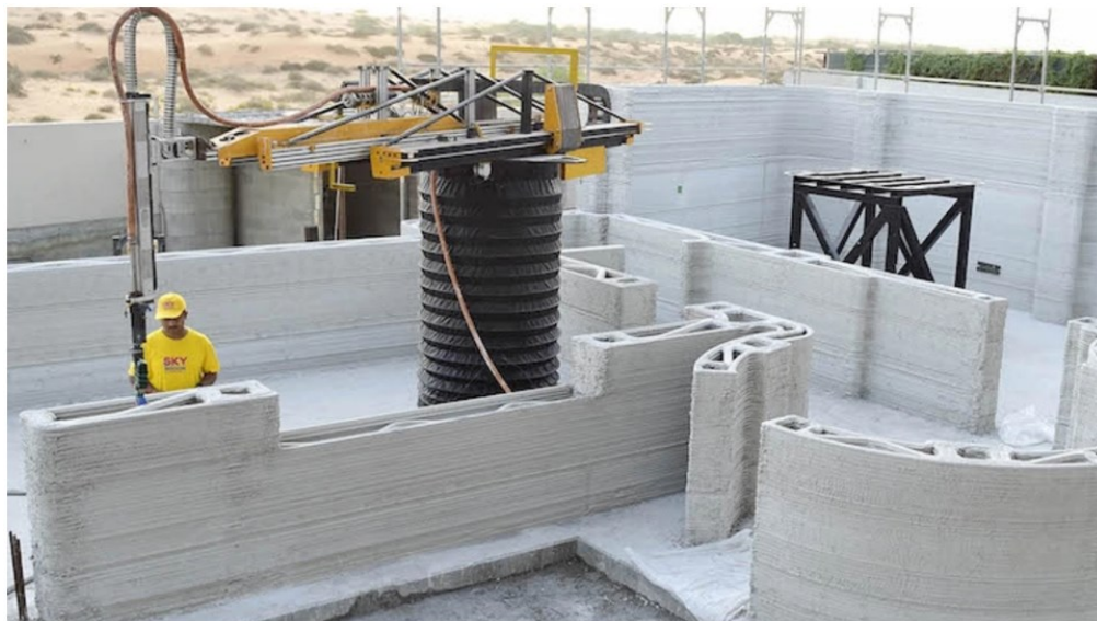
Kuva 15. Apis Cor -yritys 3D-tulosti Dubaissa hallintorakennuksen seinärakenteet käyttäen omaa laitteistoaan ja materiaaliseosta (Turney 2021).
