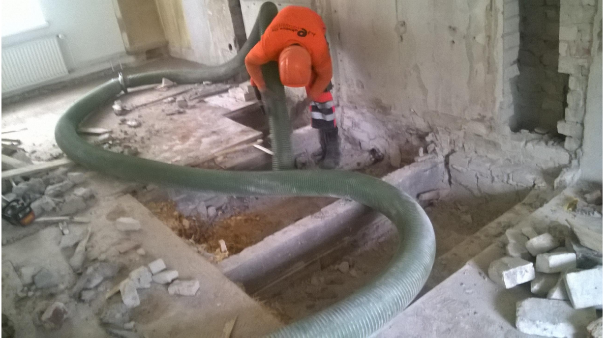
Kuva 12. Väliohjassa toimineen vanhan lämmöneristeen poistoimu
