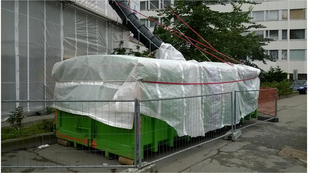
Kuva 5. Purkukuilun alapää ja lava suojattu peitteellä pölyn leviämisen estämiseksi
