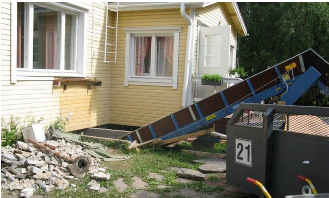
Kuva 10. Hihnakuuljettimella tapahtuva maa-aineksen poisto alapohjasta.
