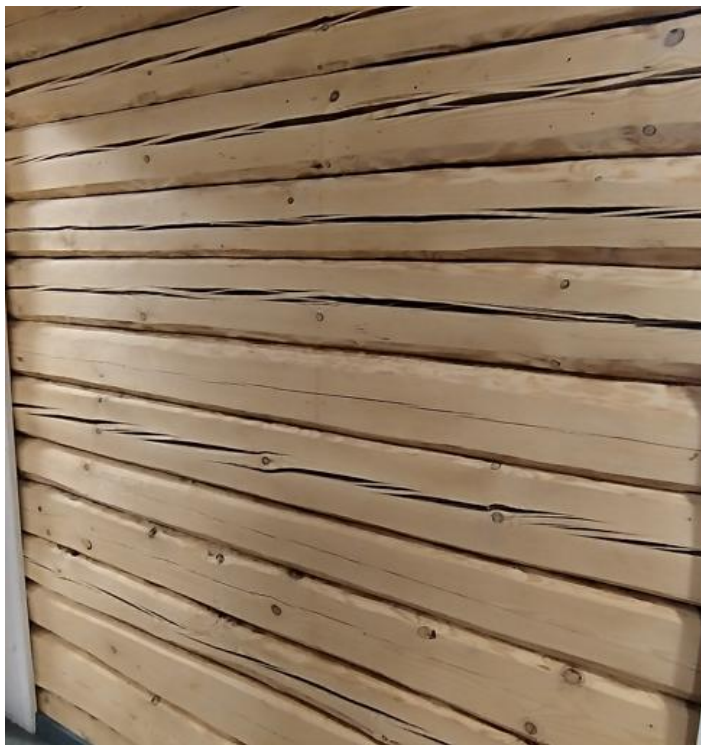
Kuva 3. Vanha tummunut hirsipinta on puhdistettu hiomalla. (Koponen 2025, CC BY-SA)
