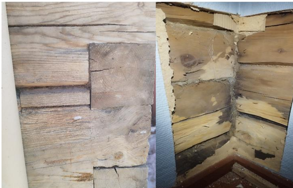
Kuva 20. Hirren korjauspala sekä vaurioituneita ja jälkeensä veistettyjä hirsii. (Koponen 2025, CC BY-SA)
