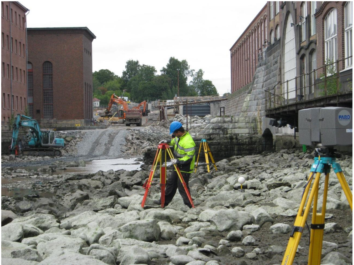
KUVA 8. Laserkeilausjärjestelyjen valmistelua (Geopalvelu Oy)
