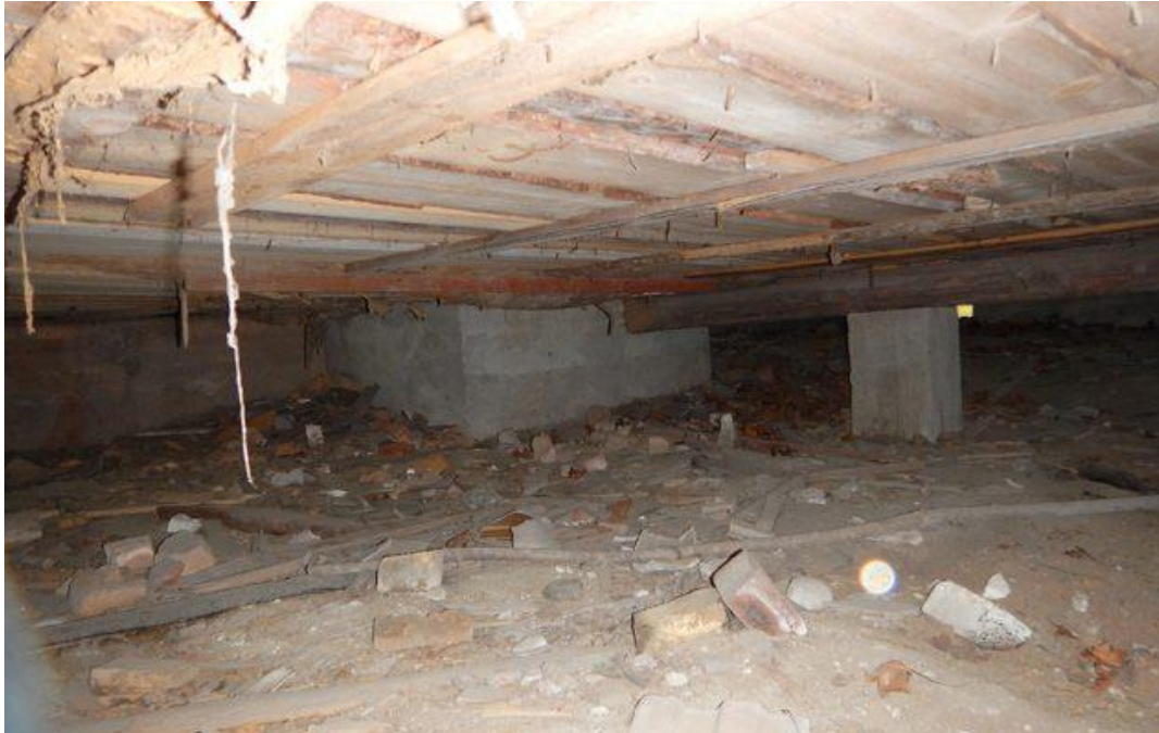
Kuva 2. Rakennuksen alapohjana ryömintätila (Rakennustaito 2022).
