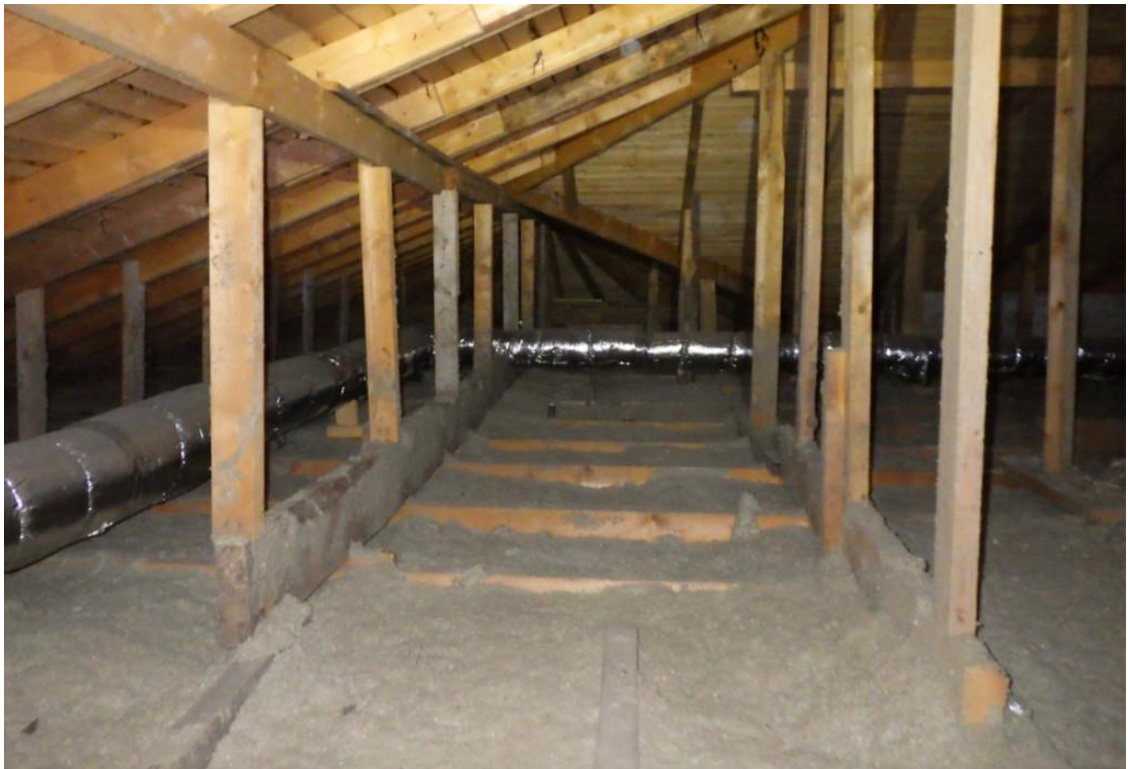
Kuva 3. Rakennuksen yläpohja (Sustera 2023).
