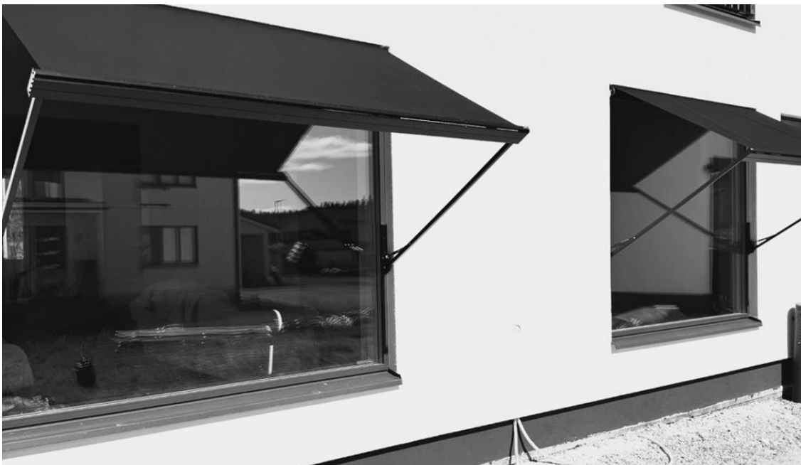
KUVA 14. Markiisit ovat suhteellisen tehokkaita järjestelmiä estämään auringonsäteilyä (Gardin s.a.)
