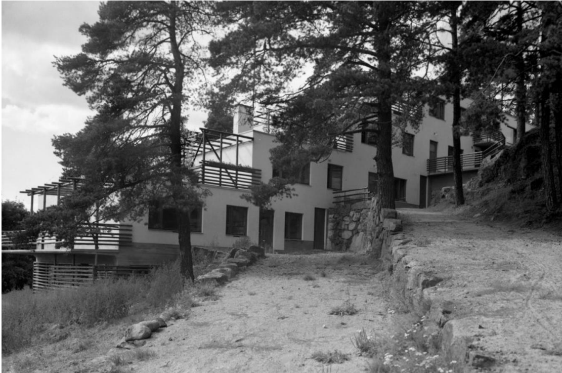
KUVA 9. Rakennusmassaa voidaan muotoilla monin eri tavoin, kuten esimerkiksi porrastuksilla, kuten Alvar Aallon suunnittelemassa terassitalossa (Alvar Aalto s.a.)
