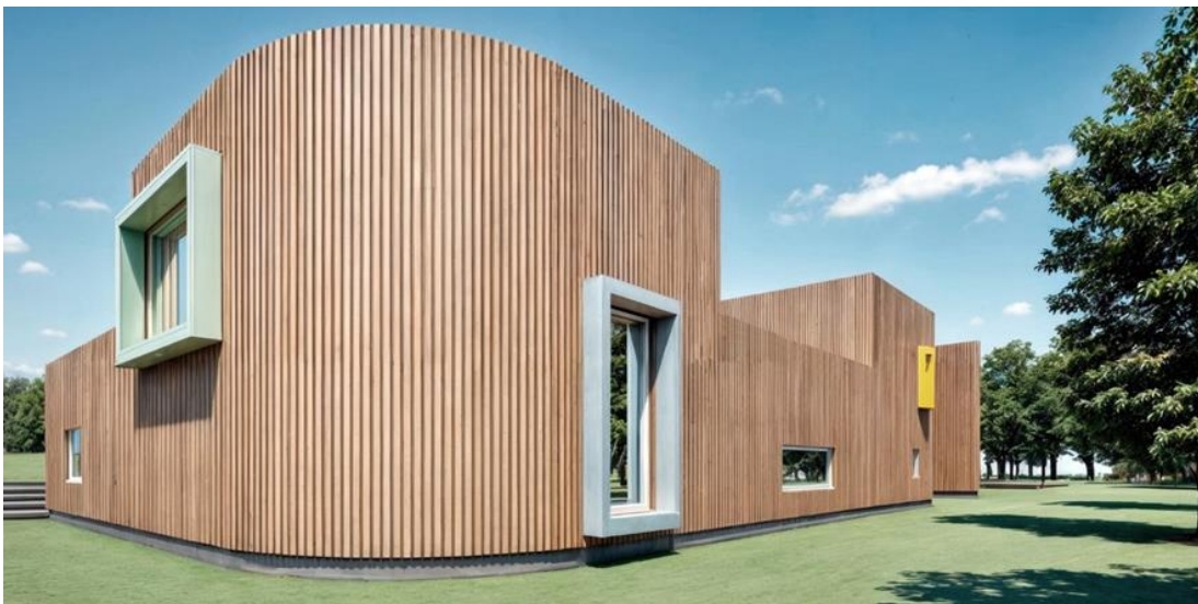
KUVA 28. Kiinteät ulokkeet ikkunoiden ympärillä
