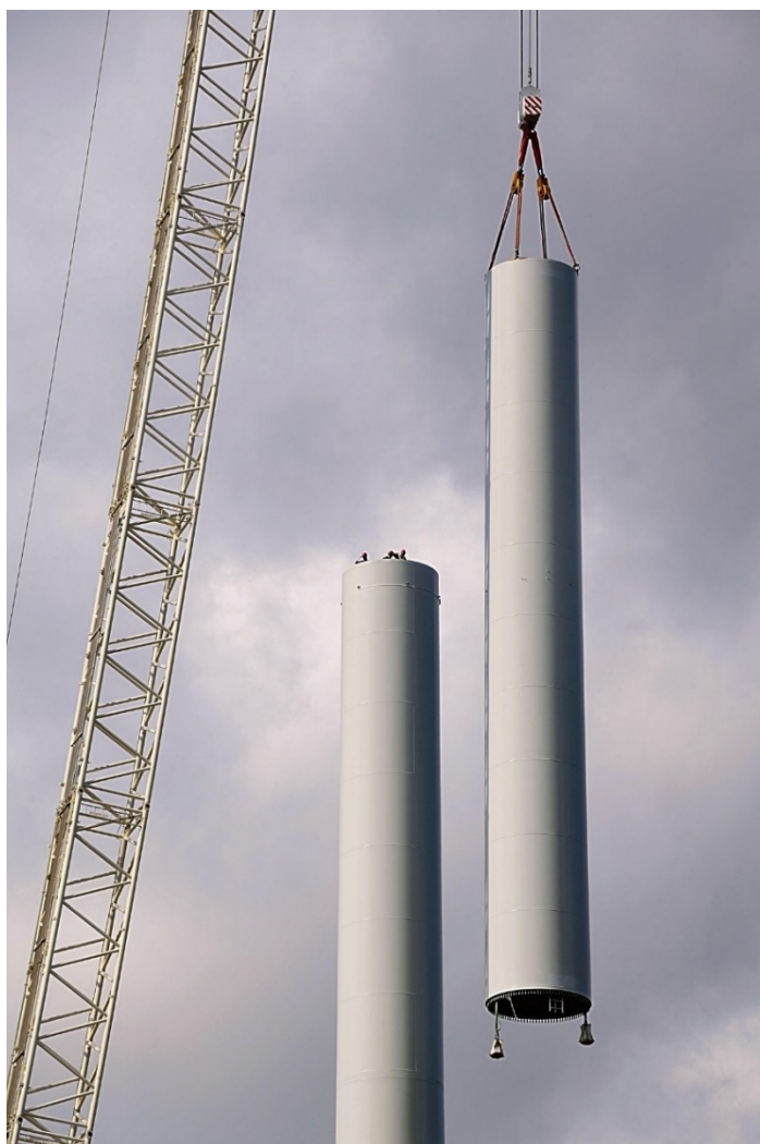
Kuva 2. Putkimaisen terästornin pystytys (Linde, 2017).
