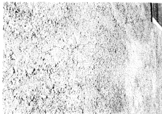
11-12. Ulkoseiniin ruiskutettua urea-vaahtoa 70-luvulla (valkoinen vahto). Rapauksessa muutamia hiushalkeamia.
