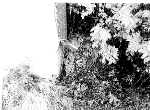
3-4. Loiskekurut tvs osin puuttu, sokkelijuuren kallistus 4. Sokkelipinnassa paikoin pintahilseilyä
