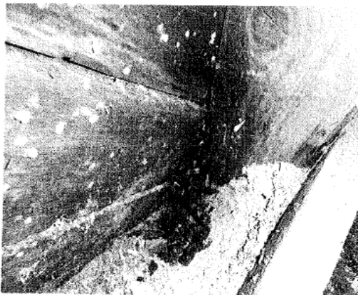
9-10. Ulkoseinissä paikoin mikrobi ja lahovikaa lämpövuodon/kosteuden tiivistymisen seurauksena (mm yläpohjatasossa)
