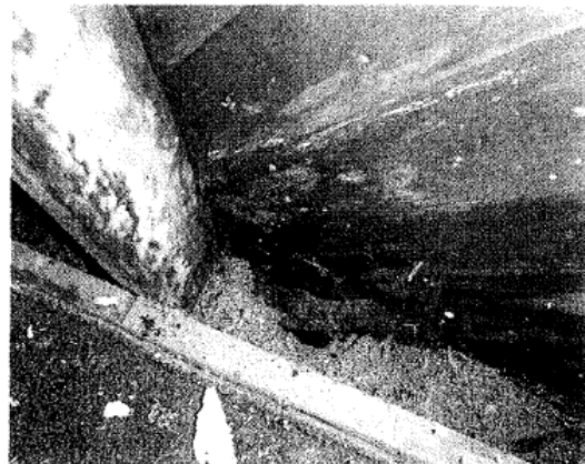
9-10. Ulkoseinissä paikoin mikrobi ja lahovikaa lämpövuodon/kosteuden tiivistymisen seurauksena (mm yläpohjatasossa)
