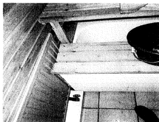
15.-16. Kellaripinnoissa paikoin kosteuden aiheuttamia vikoja. S/peh-alaosissa kohonneita kost. arvoja, amme lauteiden alla?
