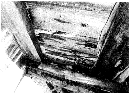
5-6. Katusivun avoterassilla puuoissa/kantavissa puuosissa laho- ja mikrobivaurioita
