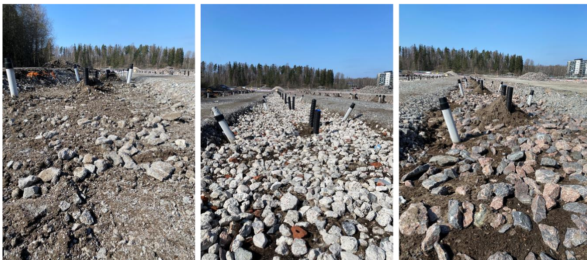
Kuvat 46–48. Vantaan koerakenteet keväällä 2025 ennen työmaan jatkumista, vasemmalta oikealle kuvattuna: kevytsorabetonimurske-, EEJ-betonimurske- ja kalliosepelirakenne. Kaikkia kiviaineksia toimitettiin työmaalle noin 100 m 3 /koerakenne. (Kuvat: Eva-Maria Tavast 2025)
