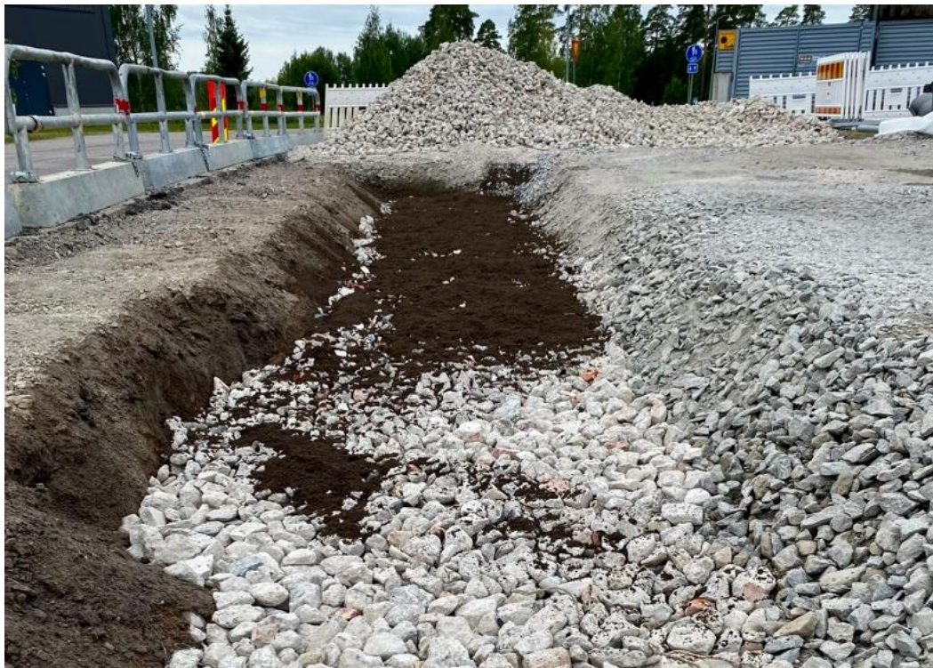
Kuva: Kantavan kasvualustan koerakenne betonimurskeella, työmaa Lahdessa 2024
