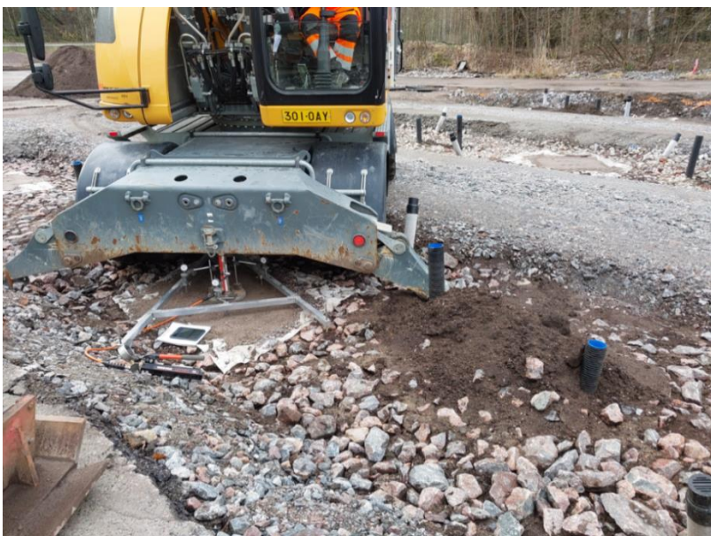
Kuva 50. Koalueen ensimmäiset levykuormitusmittaukset tehtiin 6000 kg vastapainolla huhtikuussa 2025. Kuvassa on kesken luonnonkiviainesrakenteen mittaus. Sama mittaus toistettiin kaikille koerakenteille. (Kuva: Martti Lammin-Soila 2025)
