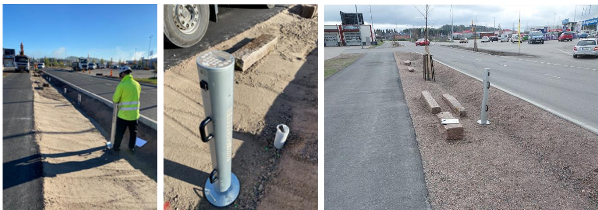
Kuvat 33–35. Valokuvia koerakenteiden Loadman-mittauksista valmiin pinnan päältä syksyllä 2024 ja keväältä 2025 (Kuvat: Eva-Maria Tavast 2024; Martti Lammin-Soila 2025)
