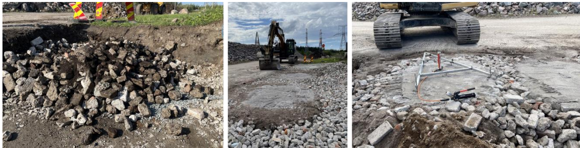
Kuvat 5–7. Kuvissa on esisekoitettu 90/150 kantava kasvualusta tuotuna koerakenteeseen. Valmiit koerakenteet, joiden pinnassa on tasauskerros kivituhkaa kantavuusmittauksia varten. Viimeisessä kuvassa näkyy levykuormitusmittaus. (Ytekki 2023b)
