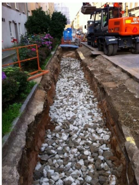
Kuva 2. Kantavan kasvualustan rakentaminen betonimurskeella Kocksgatanilla 2012 (Lindhahl 2022)
