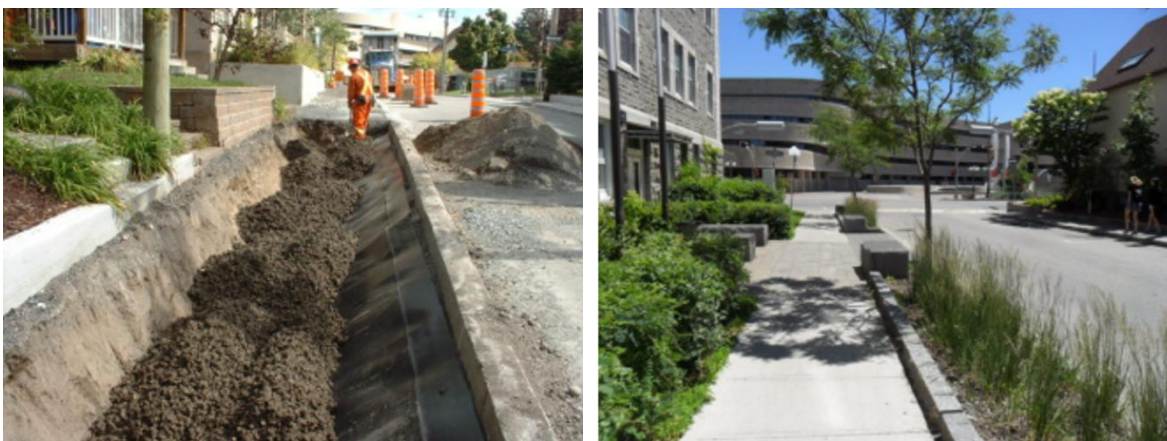
Kuvat 15–16: CU-Structural Soil™-kasvualustan levitys 2012 ja alueen kehittyminen vuonna 2019 (Greely Sand & Gravel Inc.™ 2025)
