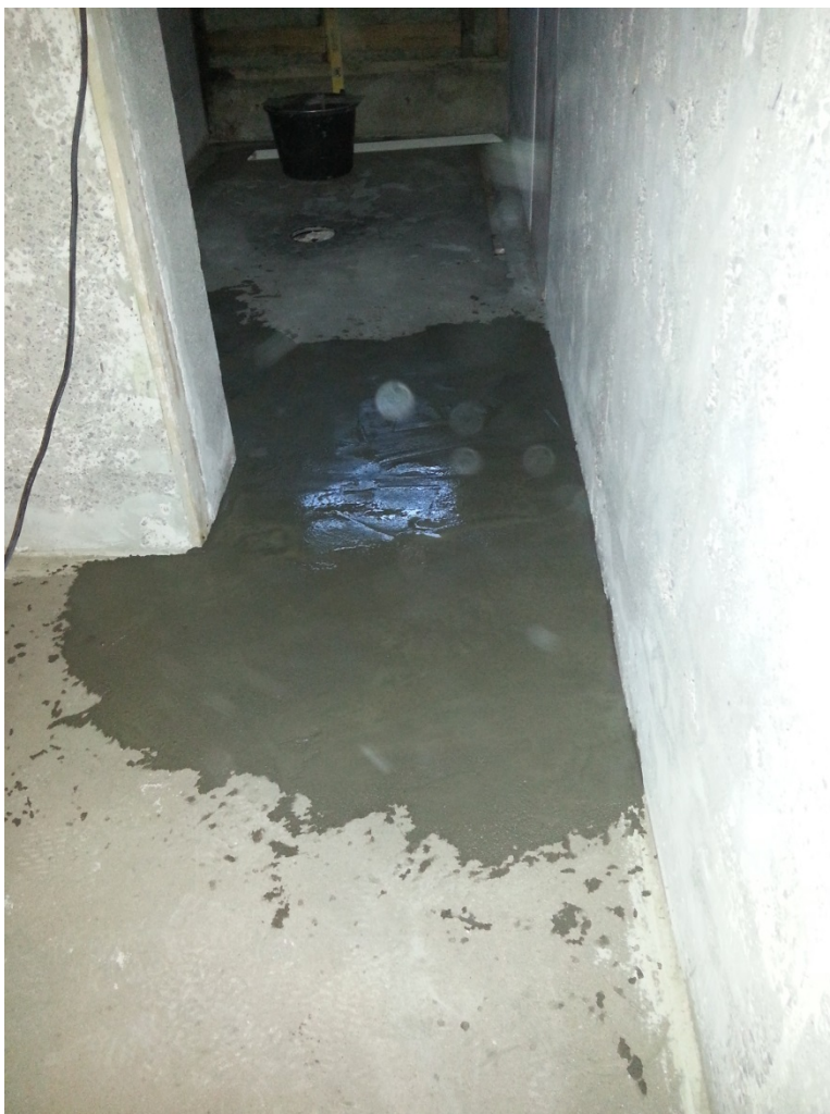
Kuva : Lattiakaatojen korotus
