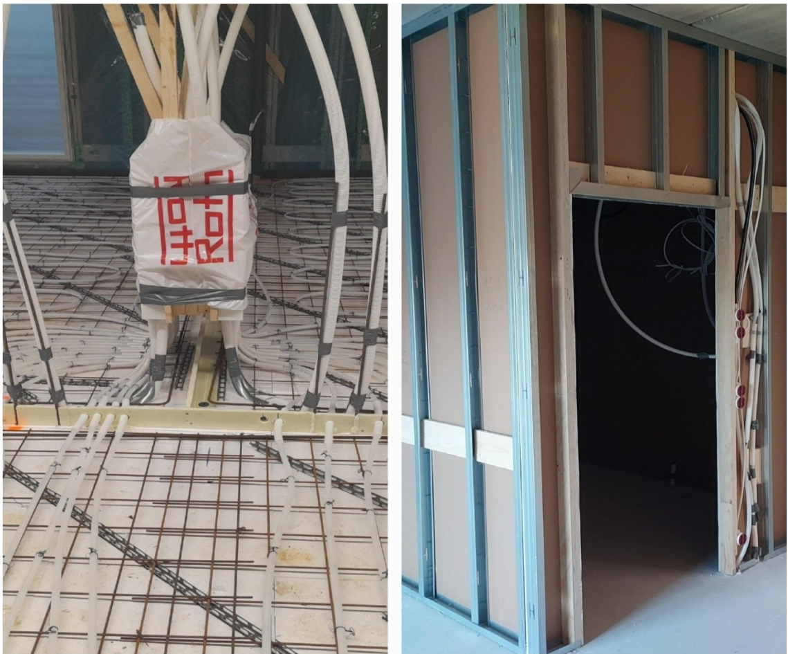
Kuva 18. Työmaakuvaus piiloon jäävistä työsuorituksista.
