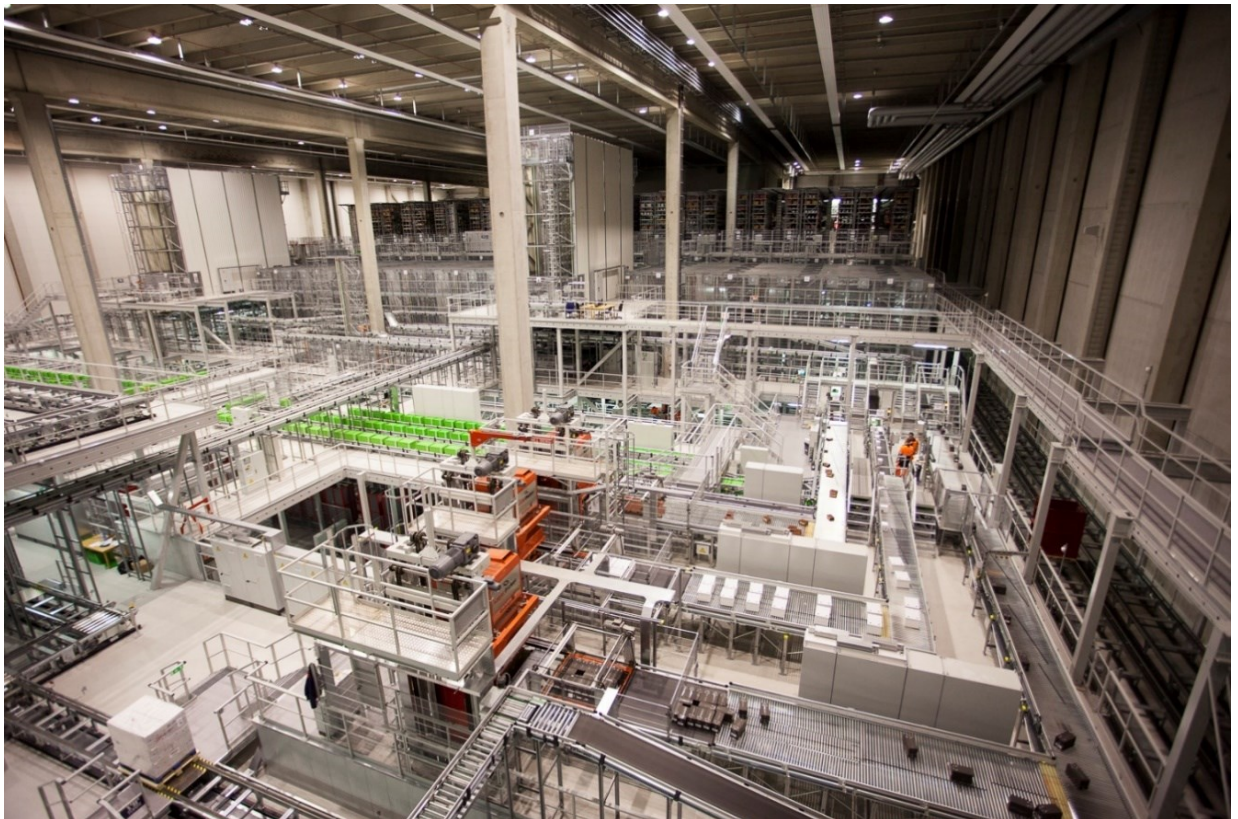
Kuva 2. Yleiskuva Inexiltä automaatiojärjestelmästä (Inex 2016)
