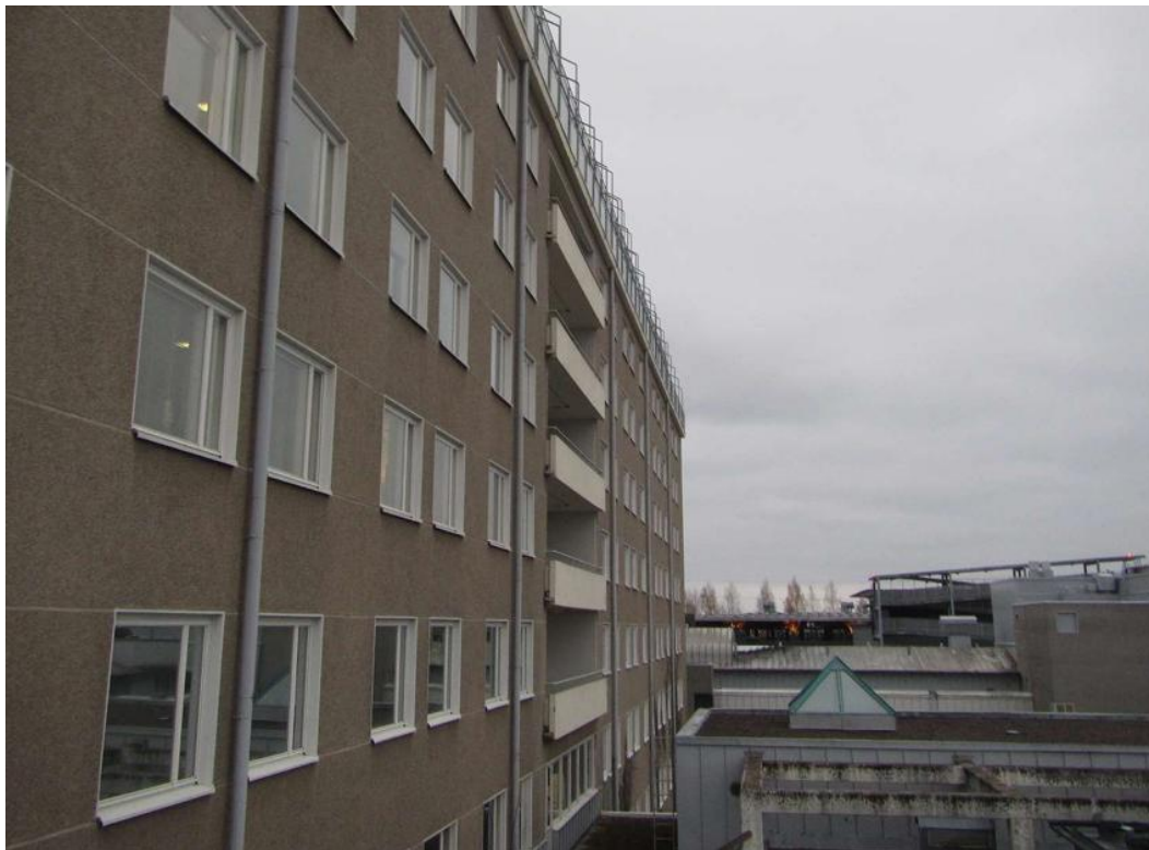
Kuva 5. Eteläpuolen parvekkeet (korjaustyöselostus 2023)
