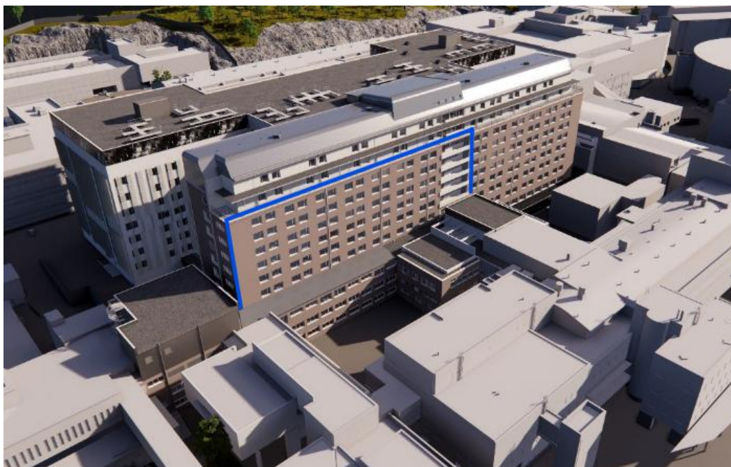
Kuva 2. Korjattava alue (muokattu lähteestä rakennusselostus 2023)
