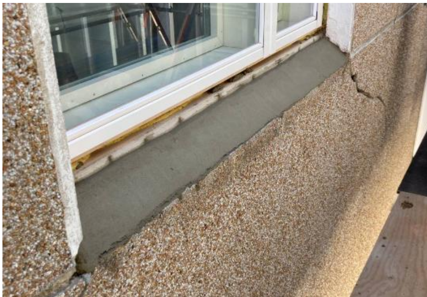
Kuva 14. Korjattu ikkunapenkki (Matilainen 2024)
