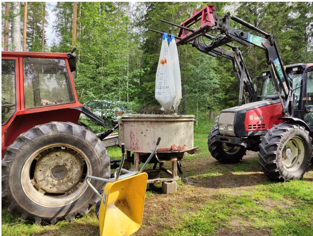
Kuva 9. Anturoiden valu toteutettiin traktorin perään tulevalla betonimyllyllä (Kolehmainen 2024).
