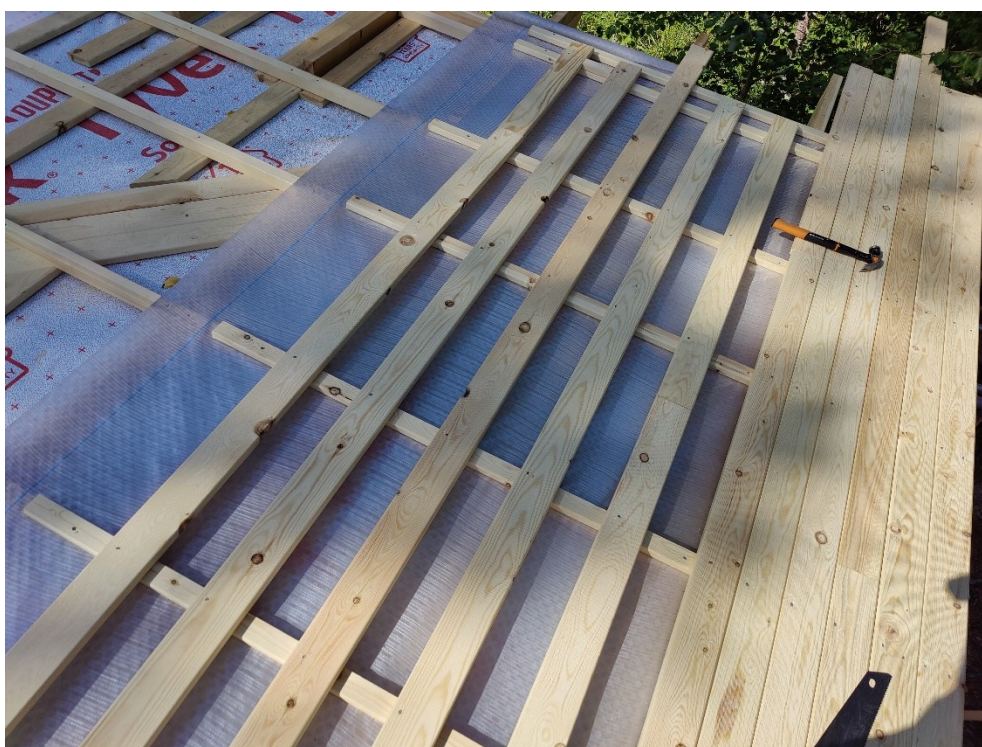
Kuva 5. Kohteen vesikattorakenne (Kolehmainen 2024)
