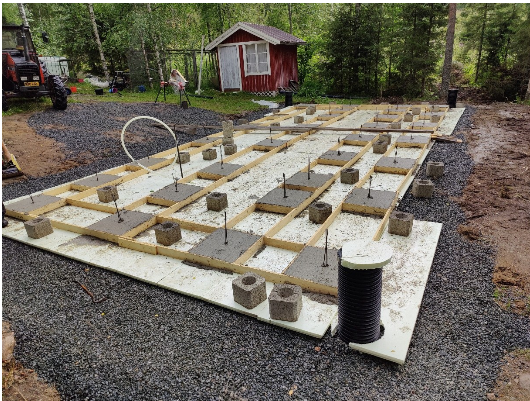
Kuva 3. Anturoiden muotit tehtiin yhtenäisistä lautamuoteista (Kolehmainen 2024).
