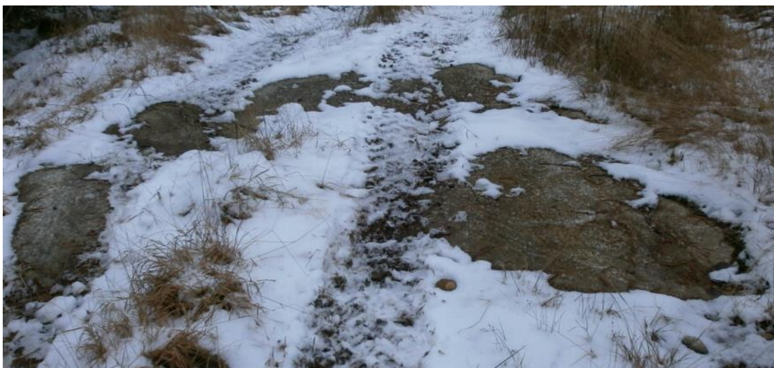
Metsäautotiellä kallio voi asettaa haasteita keräämällä vettä painanteisiin, mutta toisissa paikoissa tasainen kallio ei haittaa liikkumista.
