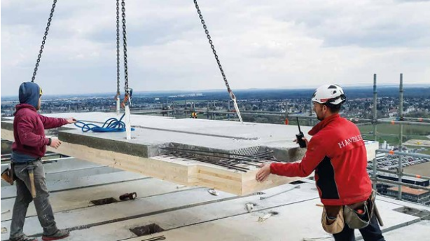
Kuvio 15. Puu-betonielementin asennus
