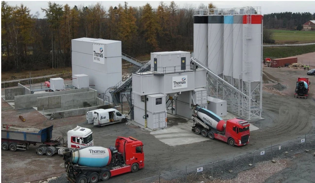
Kuva 1. Merikonttimitoitukseen perustuva Super Arcamix betoniasema (Tecwill oy, 2024b).
