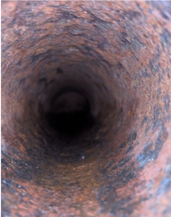
Kuva 4. Viemäriputki on puhdistettu kovapalarassilla ja se on valmis sukittavaksi.
