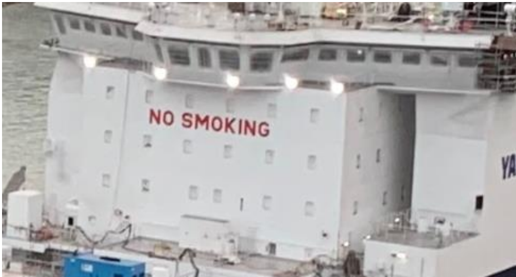
Kuva 4. Lämpökuormalle altistuva alue. Kattaa koko etuseinän, sekä osan sivuseinästä. [10].
