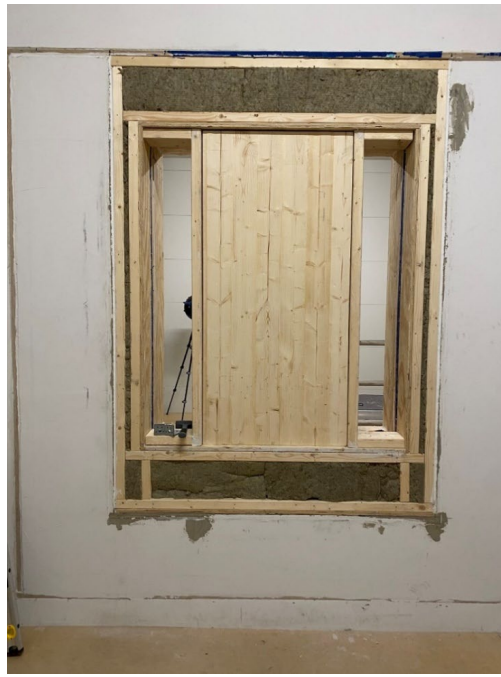
Kuva 7. Testausaukkoon tehty runkorakenne.
