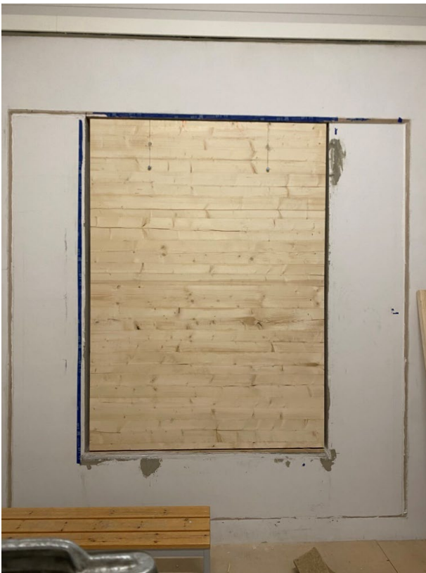
Kuva 3. Testikappale 4 lähettävästä tilasta.
