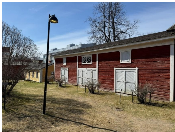
Kuva 19. Rakennus 6 julkisivu sisäpihalle päin (Holopainen 2025, CC BY)
