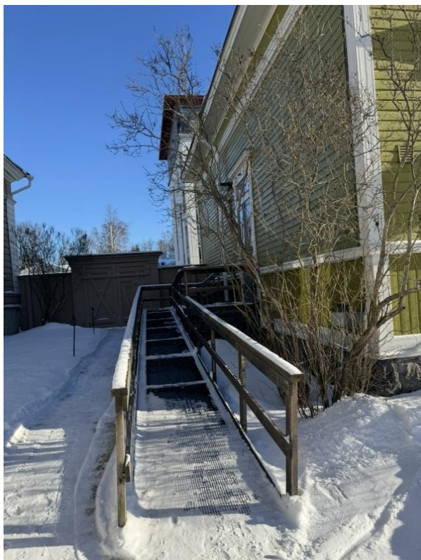
Kuva 13. Rakennus 1, esteettömän sisäänkäynnin luiska (Holopainen 2025, CC BY)
