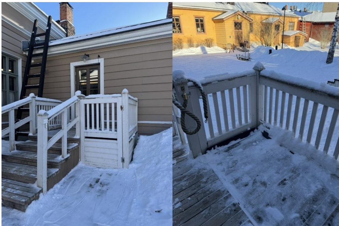
Kuva 11. Rakennus 2, sisäänkäynnin porrastin (Holopainen 2025, CC BY)
