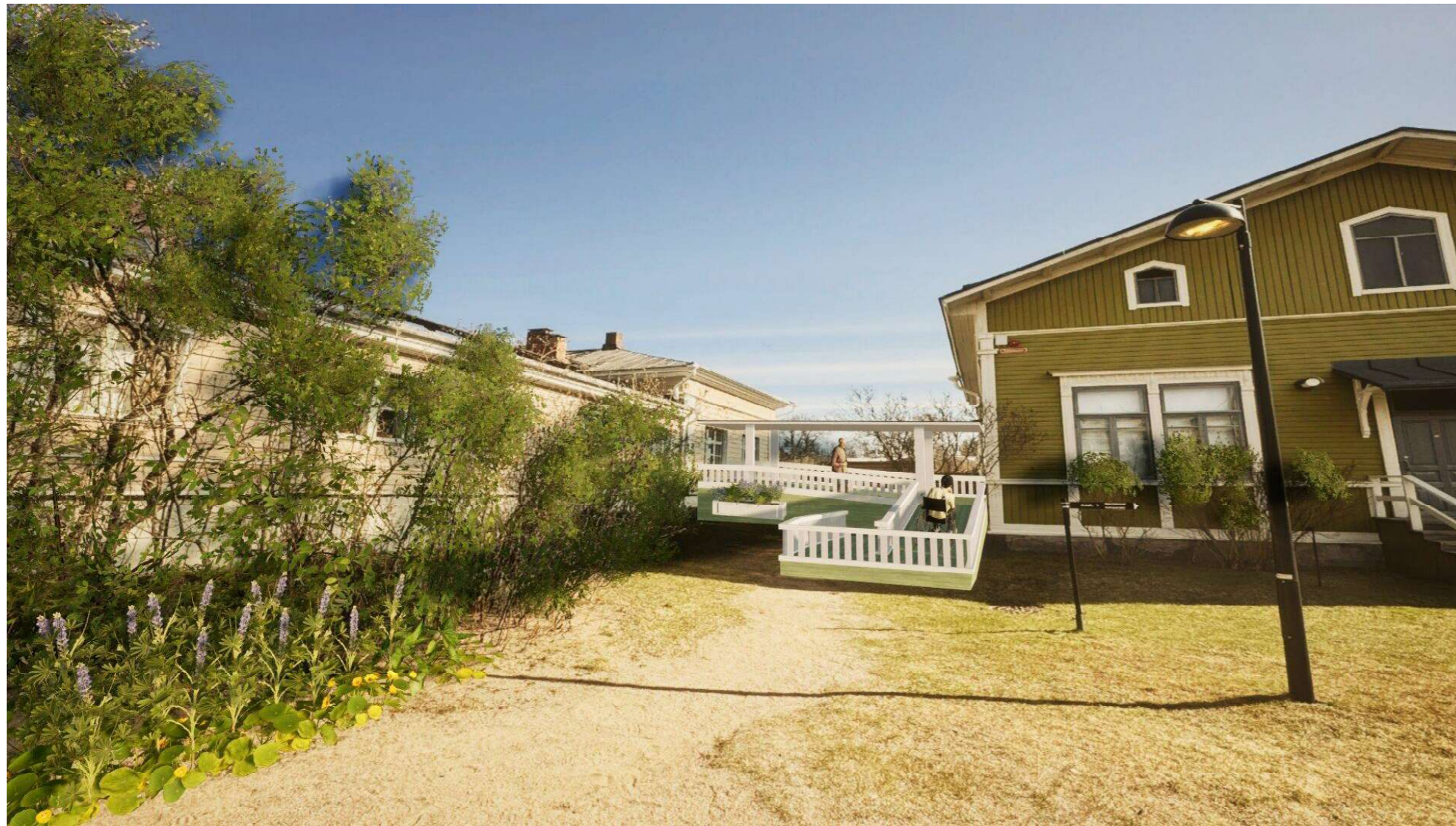
NÄKYMÄ VÄLIKAPPALEESTA SISÄPIHALTA PÄIN
