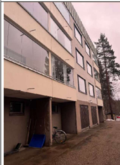
Kuva 21 Parvekkeilta vesi ohjataan lyhyillä putkenpätkillä pois.
