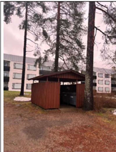
Kuva 1 Jätekatos on hyvässä kunnossa.
