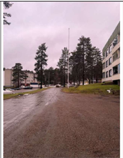
Kuva 6 6-talon pihaan johtava hiekkapäällysteinen tie on hyväkuntoinen.
