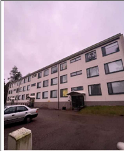
Kuva 19 Betonipintaiset elementtijulkisivut ovat hyvässä kunnossa.
