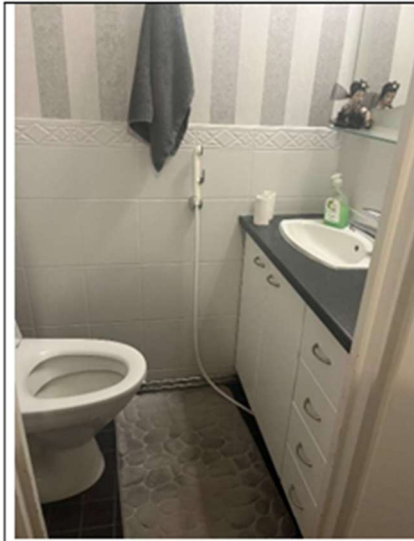
Kuva 43 huoneiston 13 wc-tila. Erilliset wc-tilat ovat kuivia tiloja.
