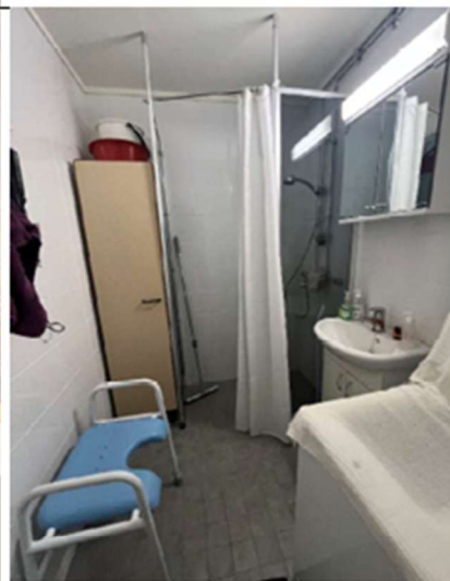
Kuva 46 Huoneisto 36 pesuhuone. Huoneistojen pesuhuoneet olivat hyväkuntoisia
