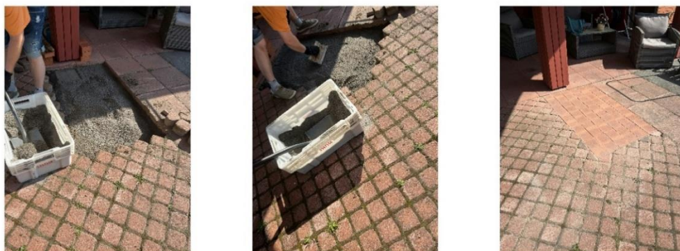
Kuva 10. Laatoitustyö ja valmis alue
