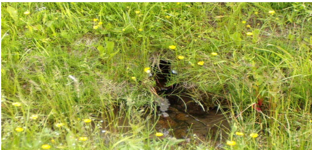
Kuva 14 (F43 Yläpohjavarusteet). Katolta tulevien sadevesien poistoputki, länsipäädyn oja.
