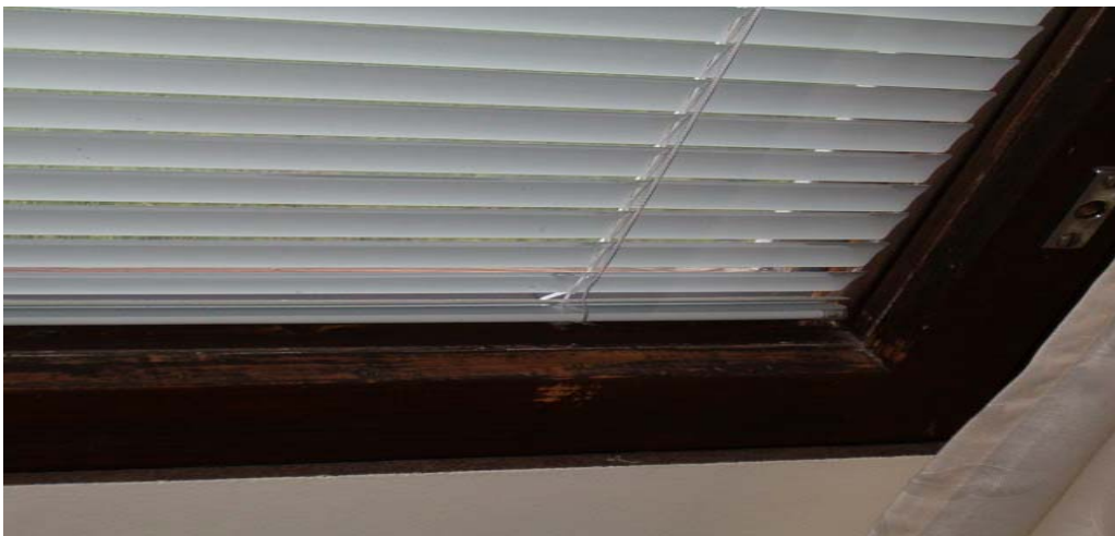
Kuva 9 (F32 Ikkunat). Alkuperäiset ikkunat tulisi vaihtaa toiminnallisesti ja lämpöteknisesti parempiin MSE-ikkunoihin.
