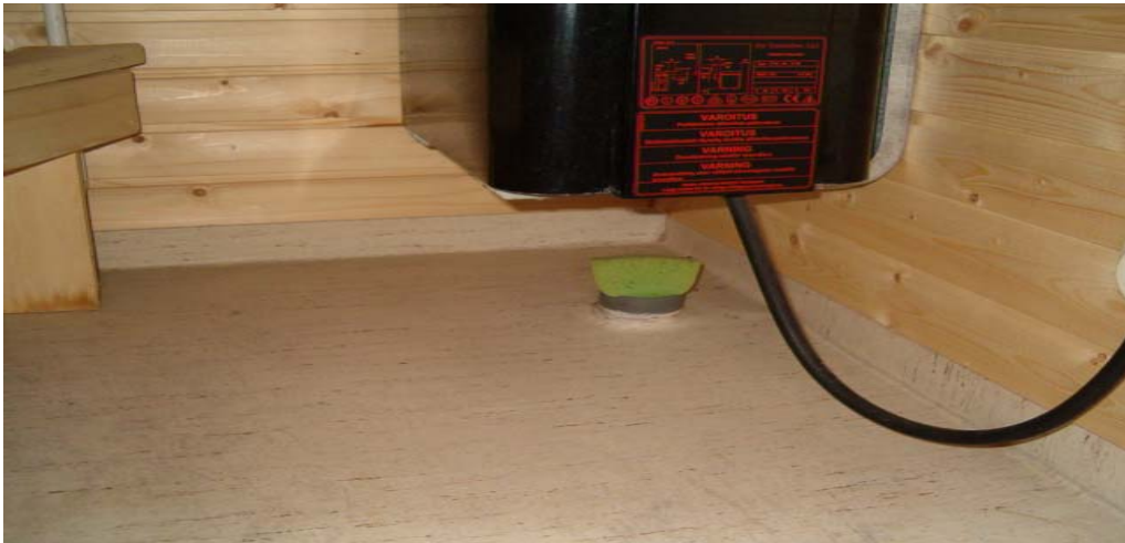
Kuva 22 (F7 Huoneistot). Joidenkin saunojen korvausilmanottoaukko, kiukaan alla on tukittu. Aukot tulisi avata, jotta saunoihin tulisi korvausilmaa.
