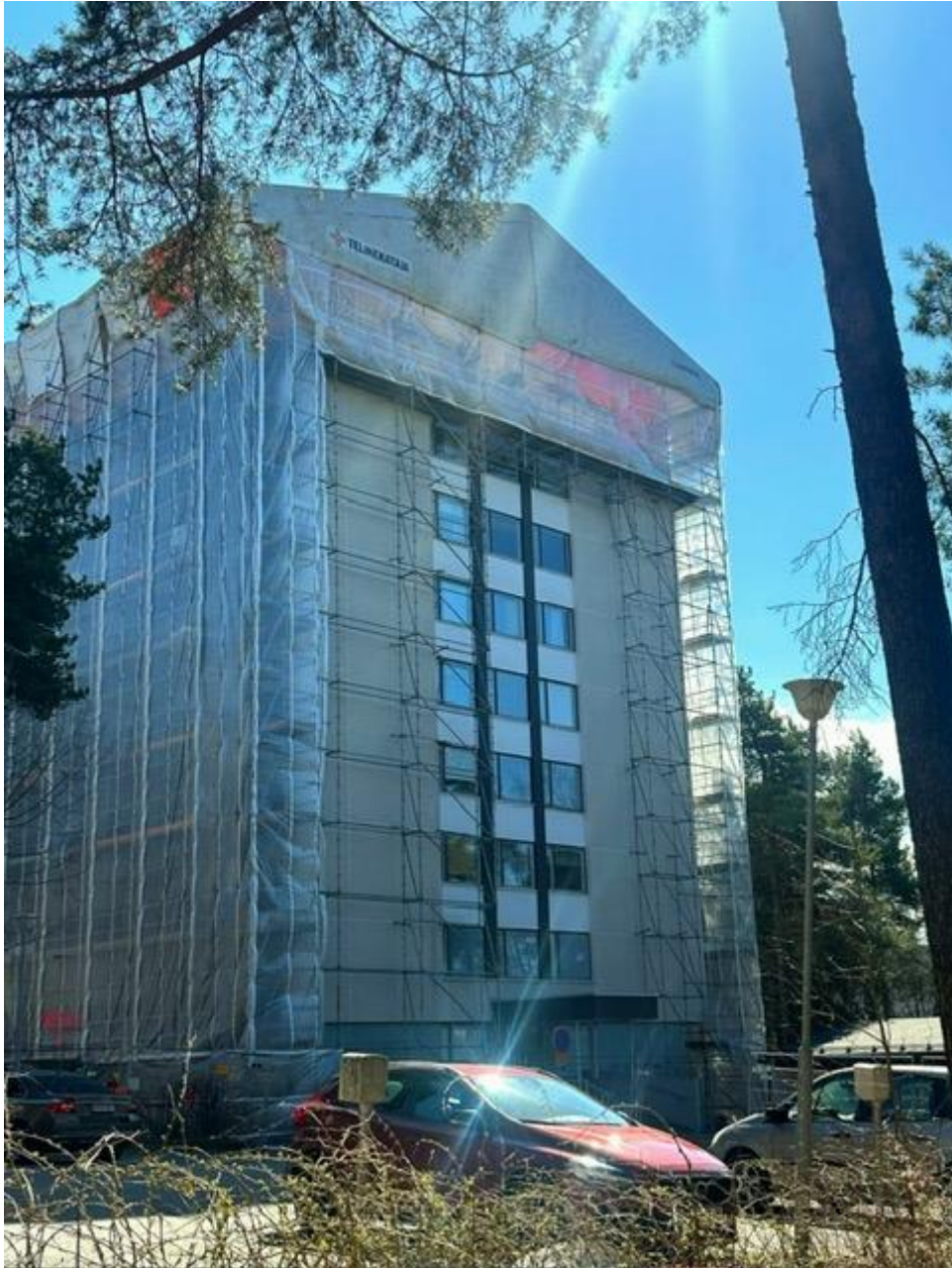
KUVA 9. Esimerkki sääsuojauksesta peruskorjaustyömaalla. (Omakuva)
